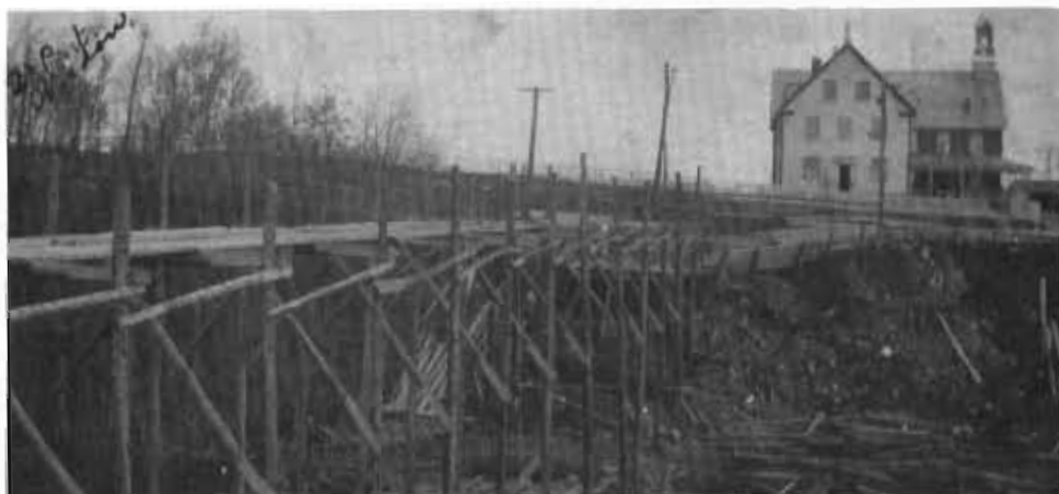
Le couvent, et le pont Tisdal en construction (1912).
