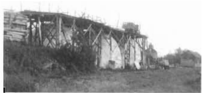
Ponts sur chevalets, sur lequel les camions circulent pour décharger le bois. À remarquer à côté, les rails du chemin de fer presque invisibles sur la photo, où l'on charge le "charcoal" en vrac.
