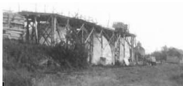
Ponts sur chevalets, sur lequel les camions circulent pour décharger le bois. À remarquer à côté, les rails du chemin de fer presque invisibles sur la photo, où l'on charge le "charcoal" en vrac.
