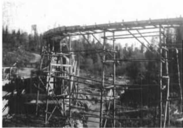
Une très ancienne installation sur le ruisseau au village, probablement construite par les Fontaine qui ont opéré le premier moulin à scie au début du siècle (avant 1907).
