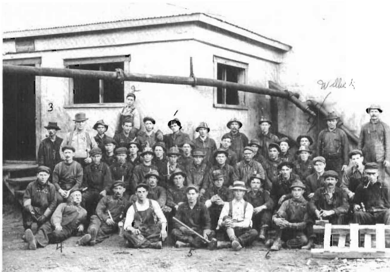
Groupe d'employés de la mine vers 1913. Sous la flèche Willie Delisle, 1- Maurice Desmarais, 2- Achille Bélanger, 3- Joseph Morin, 4- Eugène Morin, qui fut un temps opérateur du bac sur la rivière Saumon, 5- Philémon Caron, 6- Joseph Rivard. On retrouve aussi sur cette photo, Noël et Michel Lavertu, Émile et Philius Ducharme et Jean Valence.
