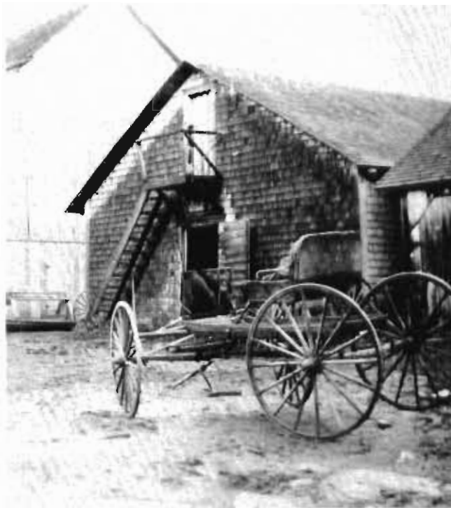
L'écurie a été démolie en 1944
