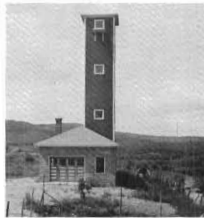
La tour de séchage construite en 1948
