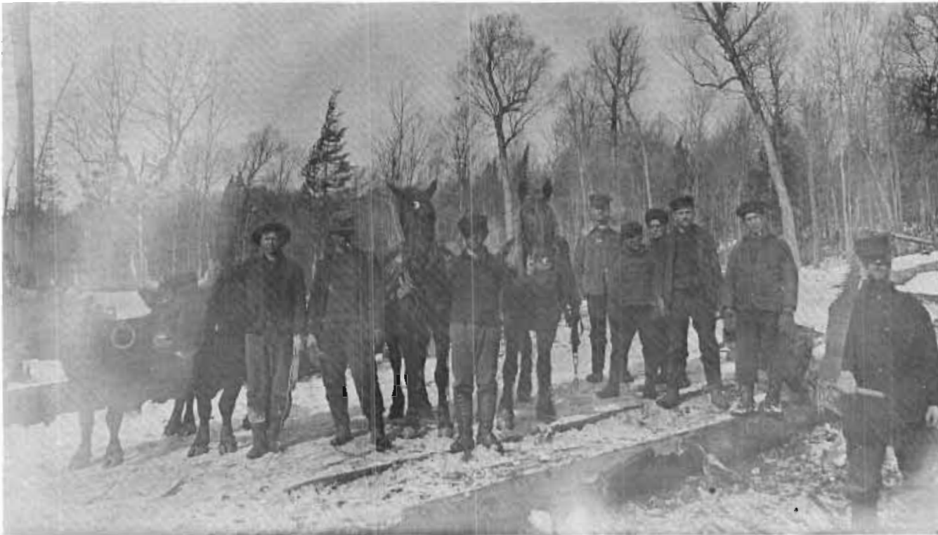
Un chantier vers 1920
