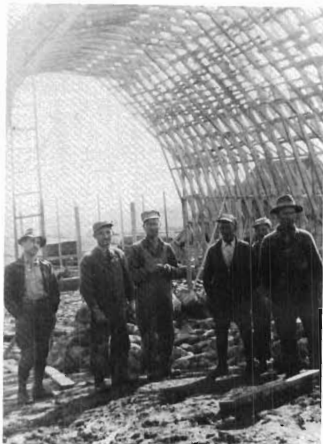
La lourde charpente équarrie à la hache a fait place à une structure plus allégée
