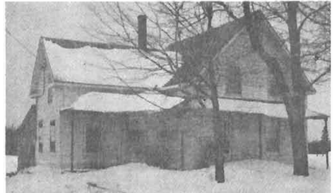
Presbytère de l'église presbytérienne du chemin de Springhill (Nantes), aujourd'hui propriété des Mongendre.
