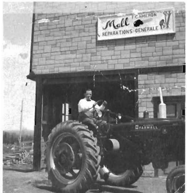
Atelier de réparations de scies mécaniques
