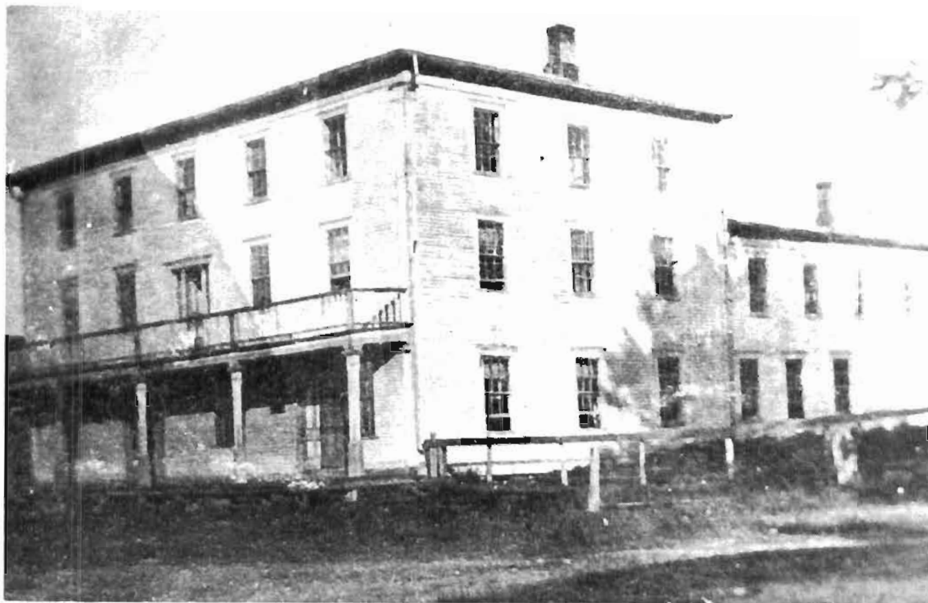
Hôtel «Manoir» que James Leonard construisait après son arrivée vers 1853 sur le site de la maison de Gratien Quirion aujourd'hui. Cet hôtel étonne par sa magnificence pour l'époque, mais n'oublions pas que Stornoway était l'une des deux étapes (avec Beauceville) pour les voyageurs entre Québec et Sherbrooke. Le voyage, qui se faisait en carrosse tiré par un cheval, demandait qu'on s'arrête à ces deux étapes pour la nuit. Donald Morrison, le fameux hors-la-loi, a dû le fréquenter dans les années 1888 alors qu'il y avait trois hôtels au village. A l'arrière se trouvait un «hall», grande salle où l'on pouvait danser ou faire des assemblées. Apparemment que beaucoup de touristes de Montréal, surtout des chasseurs, aimaient y séjourner
