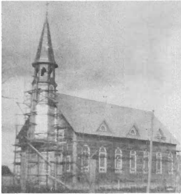
Église en construction
