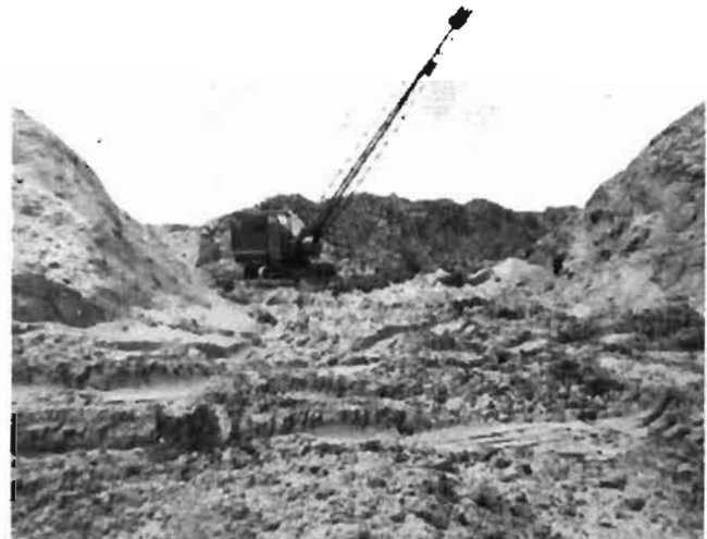
Grue munie d'un mat de 45 pieds creusant le nouveau lit de la rivière en 1948-1949.
