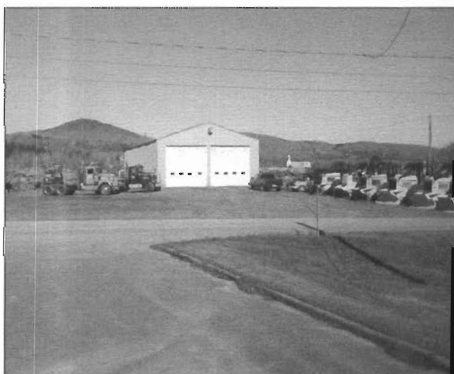
Le garage et les équipements
