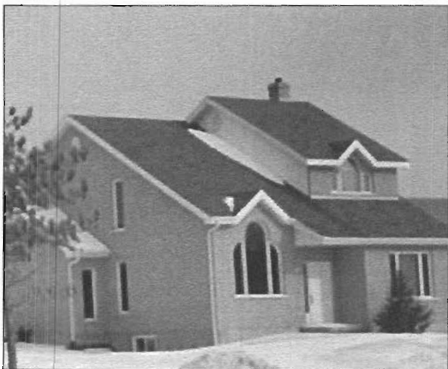
Nouvelle construction de la maison en juin 1993
