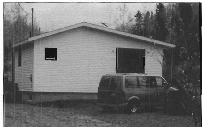
Le chalet après la rénovation
