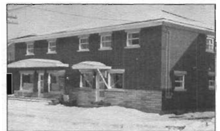
La nouvelle construction
