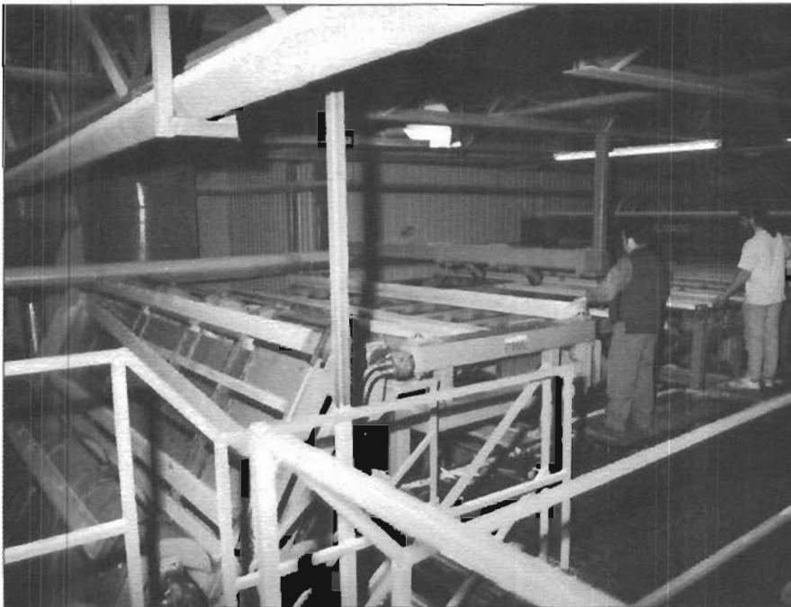
L'ébouteuse de l'usine
