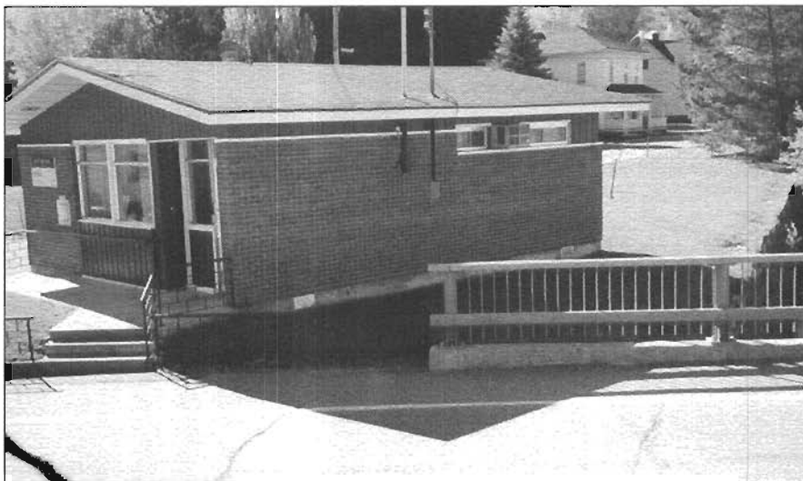
Bureau de poste actuel
