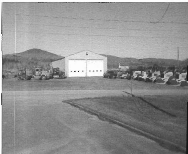
Le garage et les équipements
