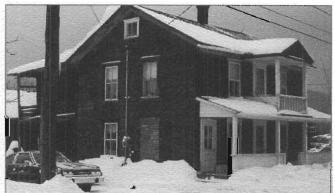
La maison familiale située au 639 rue principale, avant les rénovations majeures de 1985.
