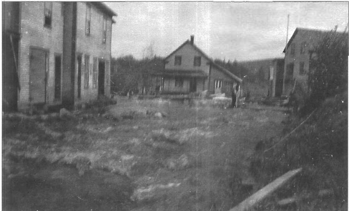
La rue Fortier est transformée en rivière; à gauche la boutique de forge (bureau de poste), au centre maison Marc Larochelle et à droite Marché d'alimentation Drapeau
