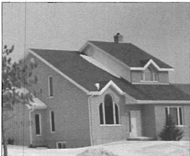
Nouvelle construction de la maison en juin 1993
