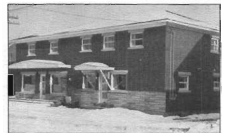
La nouvelle construction
