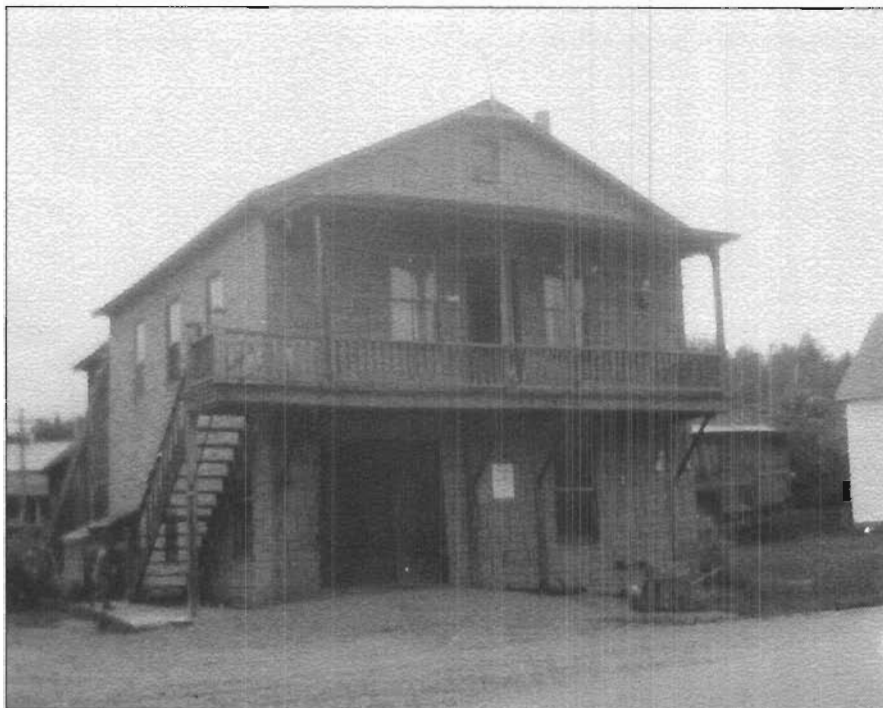
Boutique de forge Alfred Campagna sur le site actuel du bureau de poste
