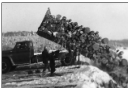
Dommage pour transformation du bois sur la rivière à Pierre
