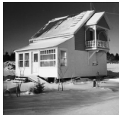
Maison d'été, seul témoin du passé
