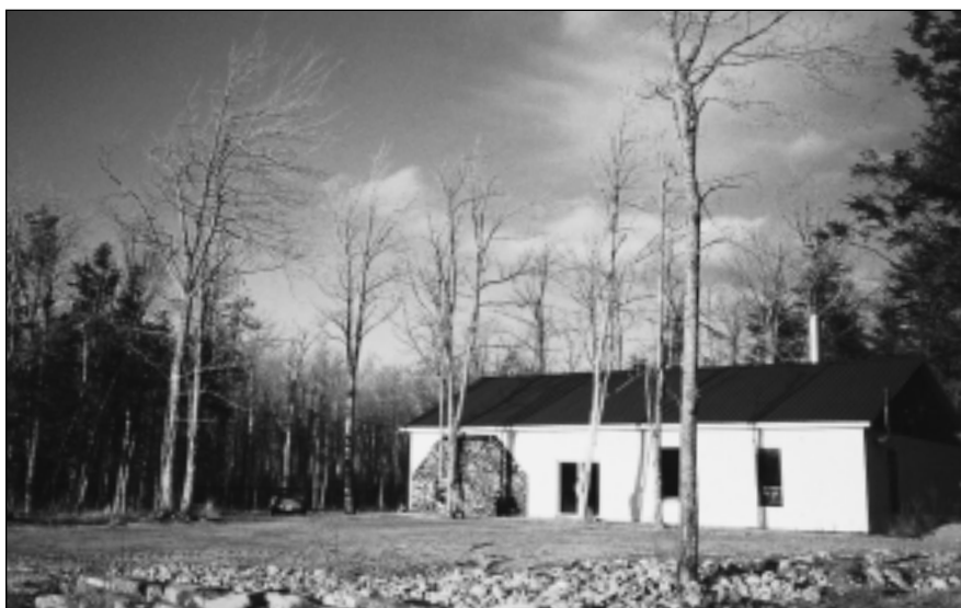
Cabane à sucre construite en 1999
