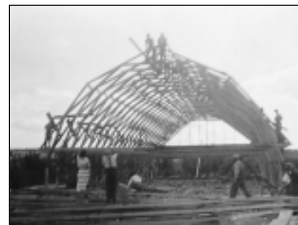
La construction de la porcherie à la fin des années 1940
