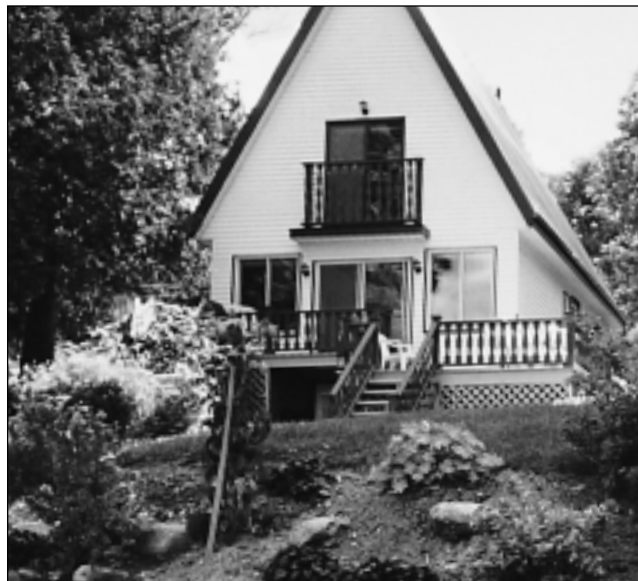
Chalet construit en 1983 à Saint-Romain
