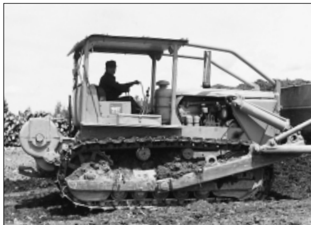
Le bulldozer acheté en 1969
