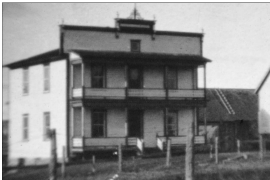
Maison de M. Francis Roy au 104, rue du Moulin, où la messe est célébrée entre le 1 er octobre 1903 et le 25 décembre 1903. (Collection Paysmage)
