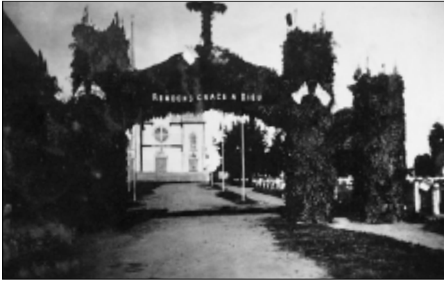
Trois arches identiques sont construites dans le village pour signaler l'ordination de l'abbé Aimé Tardif, en juillet 1932. (Collection Gaétane Beaudoin)
