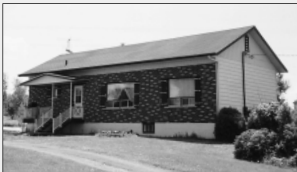
École no 8, sur la route 108 est, déménagée sur la route 108 à Saint-Romain. (Photo : André St-Pierre, juillet 2001)
