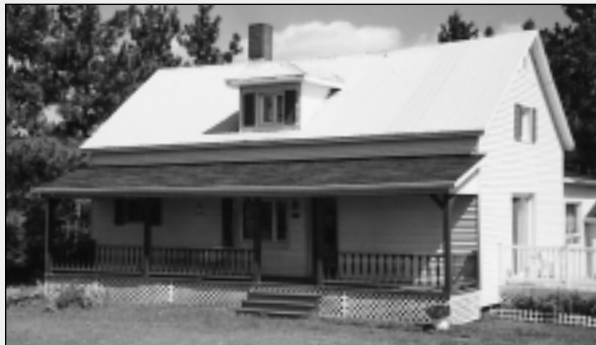
École no 2, première partie du 8 e rang Sud, modifiée sur place. (Photo : André St-Pierre, juillet 2001)
