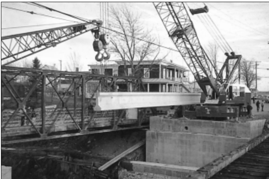
Construction du nouveau pont, 1971. (Collection Paysmage)
