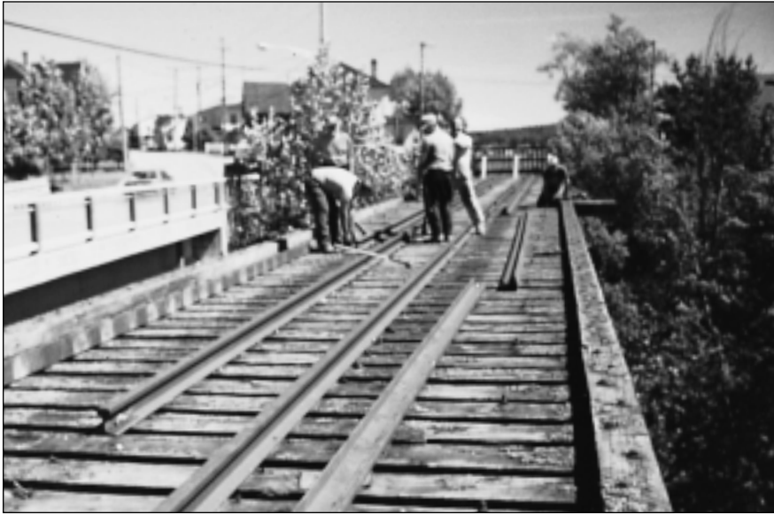
Démantèlement de la voie ferrée, en 1991. (Collection Gemma Tardif)
