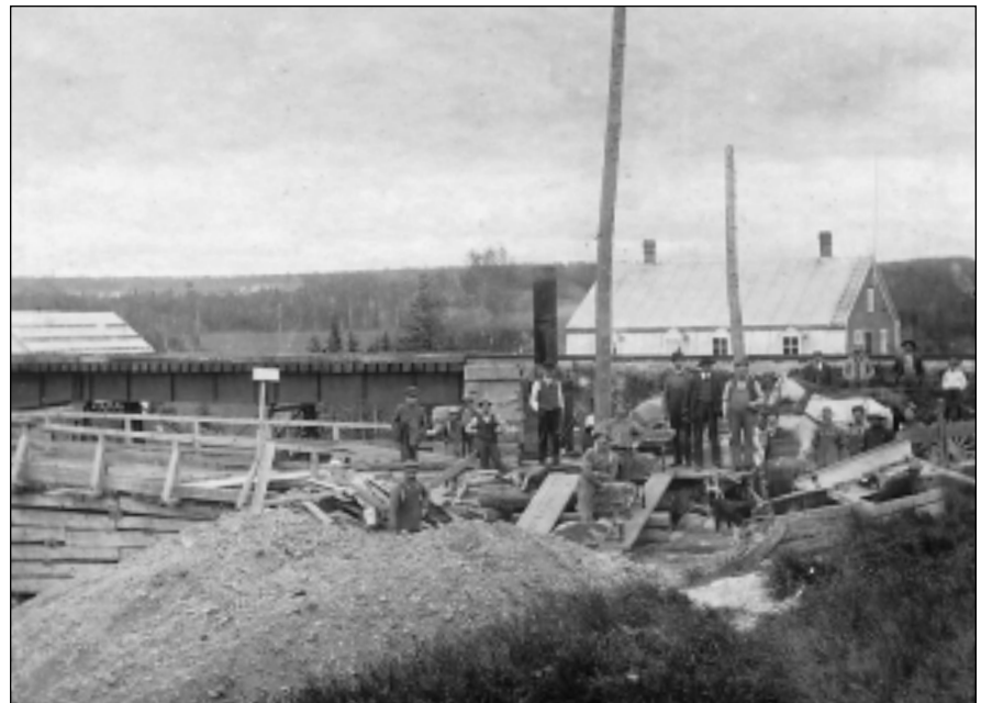
Début de la construction du pont de fer, en 1912. (Collection Gemma Tardif)
