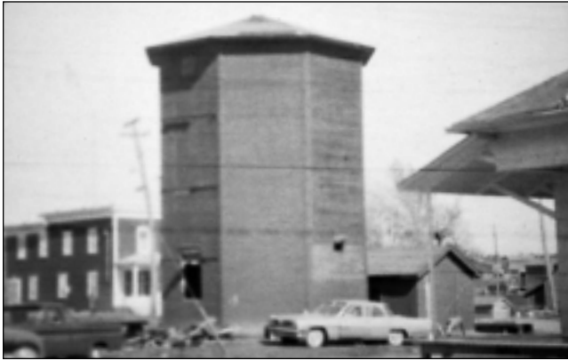
M. Albéric Bégin commence les travaux de déménagement de la tour à eau. (Collection Jean Bégin)
