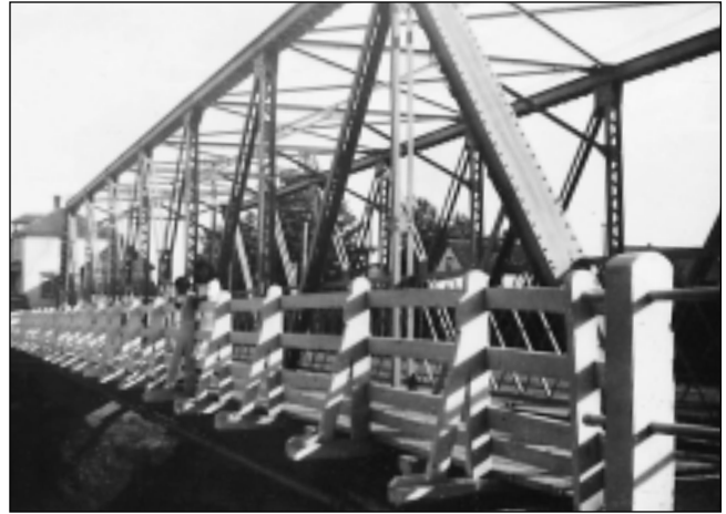
Une passerelle est ajoutée au pont du village pour accommoder les piétons. (Carte postale non datée, Collection Irène Bégin)
