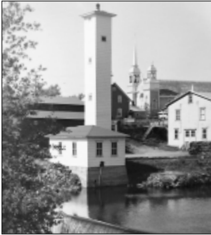
Cabane des pompes à feu munie d'une tour pour le séchage des boyaux à incendie. (Collection Normand St-Pierre)
