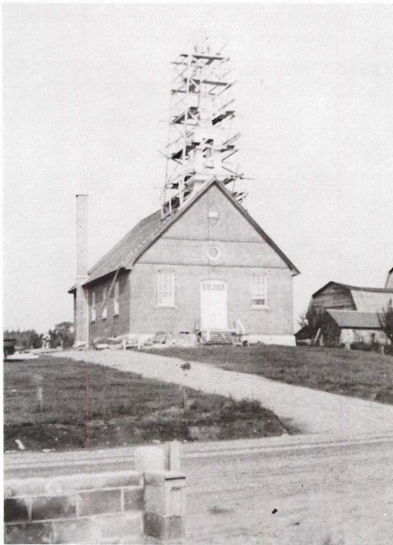
CONSTRUCTION DU CLOCHER.
