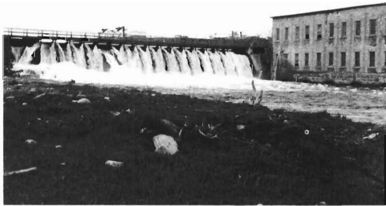
Le barrage et l'usine de pulpe de la Lake Megantic Pulp Co. (Ville de L. M.).
