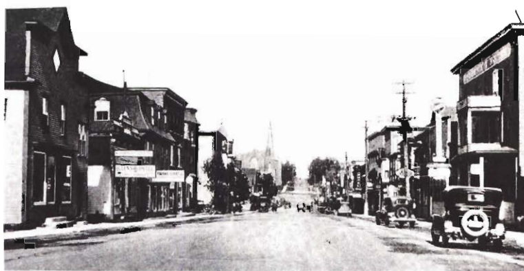
Maple Street (Frontenac) en 1924. La rue boueuse de l'époque Morrison a fait place à une belle artère macadamisée, bordée de beaux édifices (Ville de L. M.).
