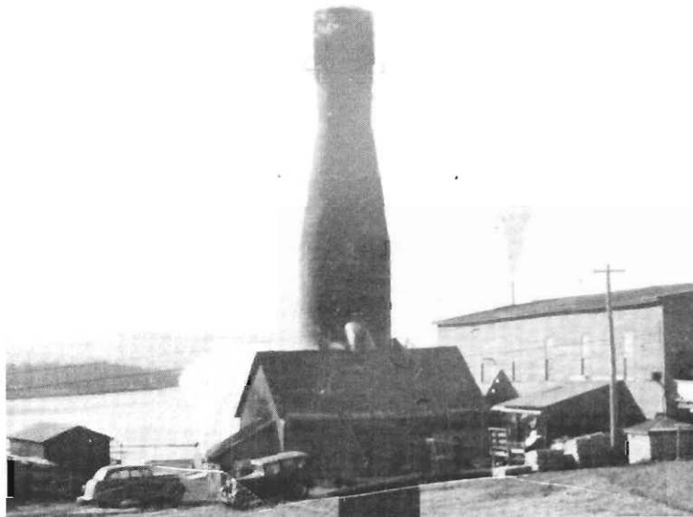
La scierie de la Lake Megantic Pulp Co. , construite en 1897 sur le site des Moulins Nantais, demeure active malgré la crise ( Ville de L. M. ).
