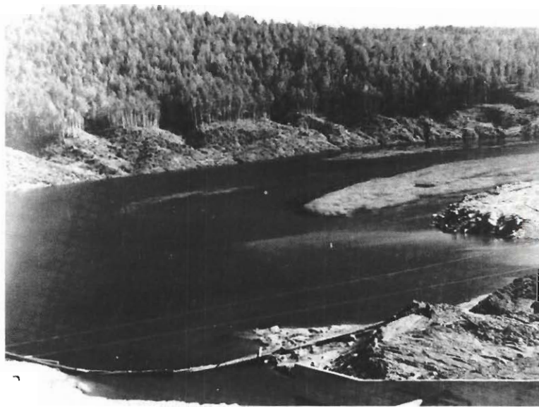
Le site Gayhurst, en 1954, à l'époque de la construction du barrage (Coll. Écho de Frontenac ).
