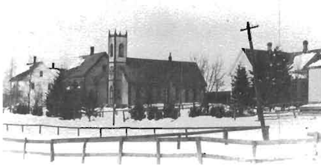
Église anglicane, rue Saint-Jean Ouest
