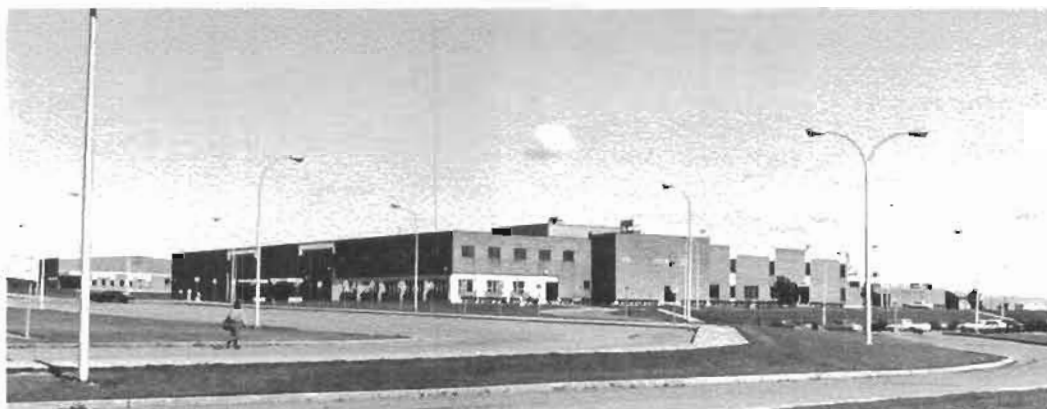
L'école polyvalente Louis-Saint-Laurent ouvre ses portes à l'automne 1972. Construite pour recevoir 1300 étudiants, aujourd'hui en 1986-1987, 850 étudiants y reçoivent l'enseignement de 57 enseignants. À la direction il y a quatre directeurs, le principal est M. Henri Lemelin, deux directeurs adjoints et un directeur adjoint en administration
