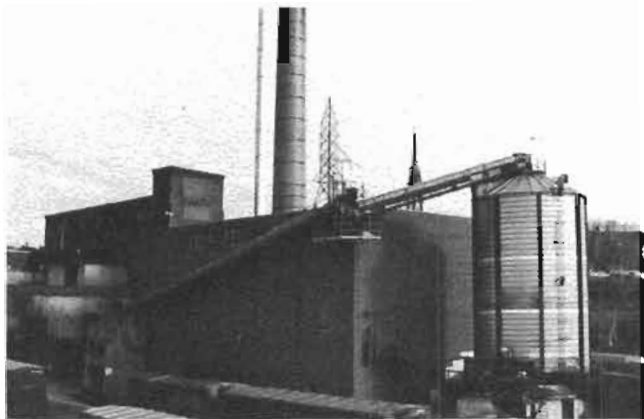
Bâtisse centrale des bouilloires (Photo 1986)
