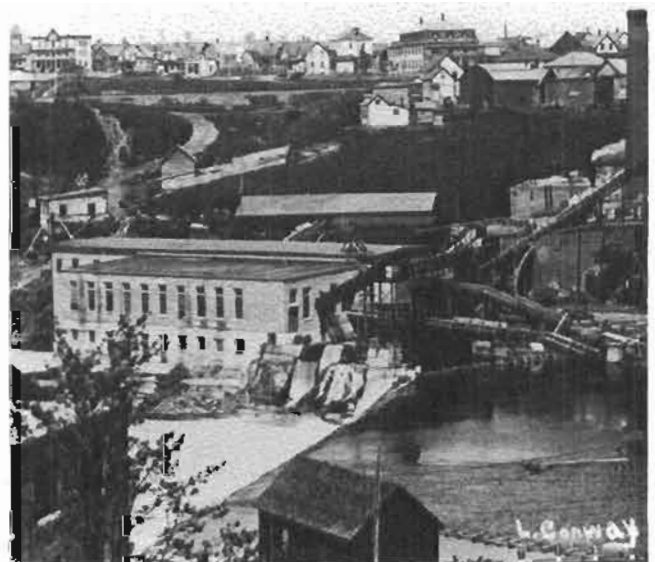
Moulin à pâte mécanique n° 5 à gauche, construit en 1910. Il a été ajouté au bâtiment du moulin à scie. Il fut transformé en département du bois « Wood Room ». Aujourd'hui, il abrite le plan d'eau filtrée pour la pulperie et la machine à carton
