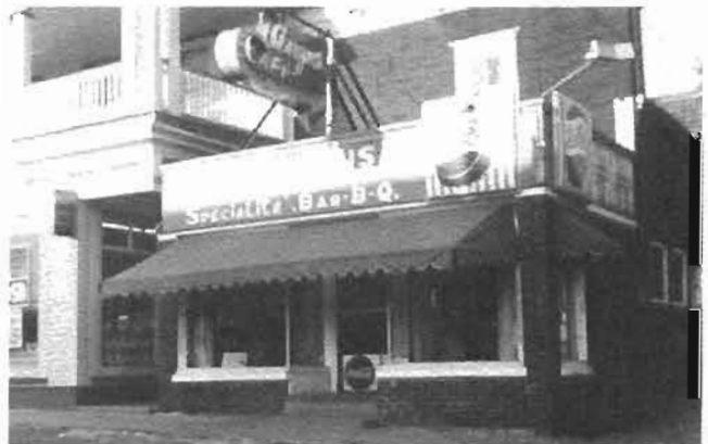
Après les réparations
