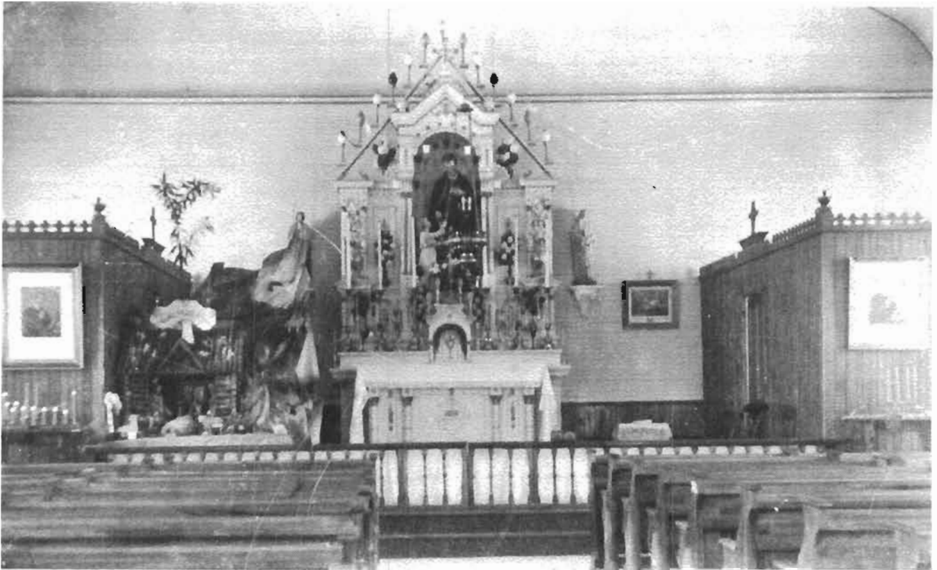
Intérieur de l'église Saint-Louis-de-Westbury bâtie en 1894
