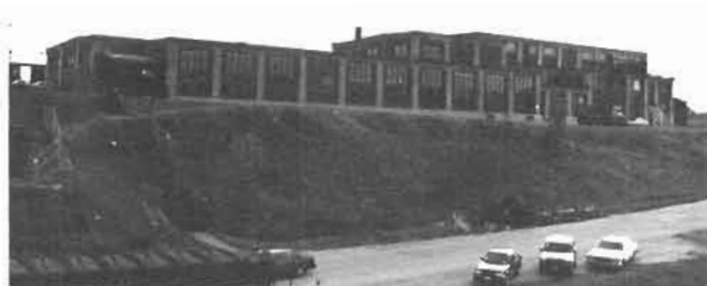
Usine de pâte mécanique, construite en 1920: elle opéra jusqu'en 1965. Depuis elle sert d'atelier d'usinage et de magasin général pour la compagnie. (Archives 1986)
