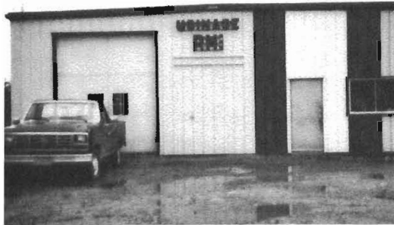
Usine d'Usinage R.M. Enr., rue Angus sud
