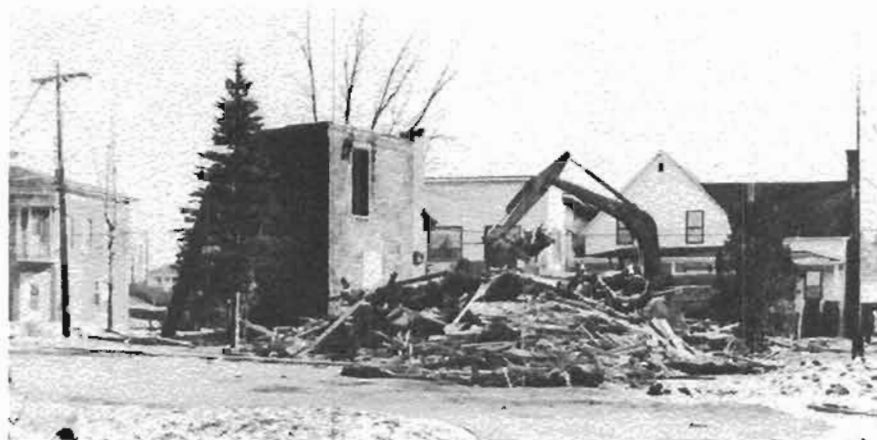
La voûte de l'hôtel de ville, construite par M. Jos Vallée, contremaître, en 1931. (Archives 1980)
