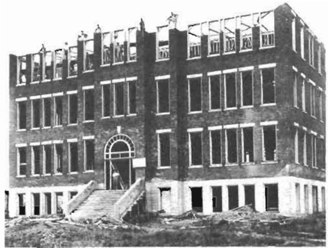
Construction du collège en 1916
