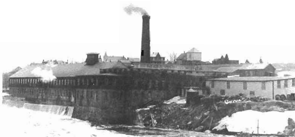
Bâtiment des machines à papier 1 et 2, vers 1907
