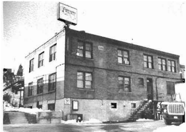
Centre d'administration. (Archives 1986)
