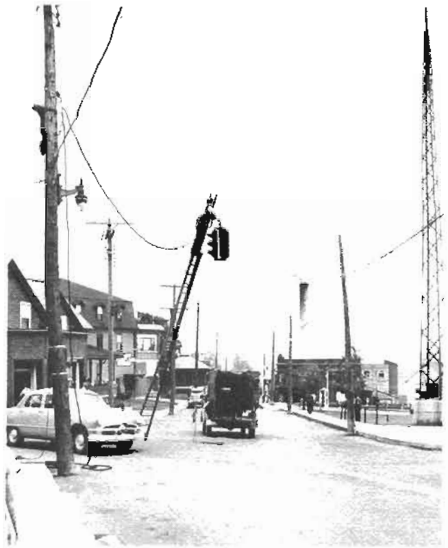
Installation des feux de circulation à la jonction des rues Angus, Saint-Pierre et Saint-Jacques, le 21 juin 1951
