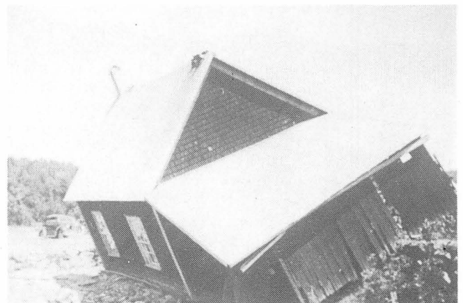
Maison penchée de M. Chabot lors de l'inondation de 1943.
