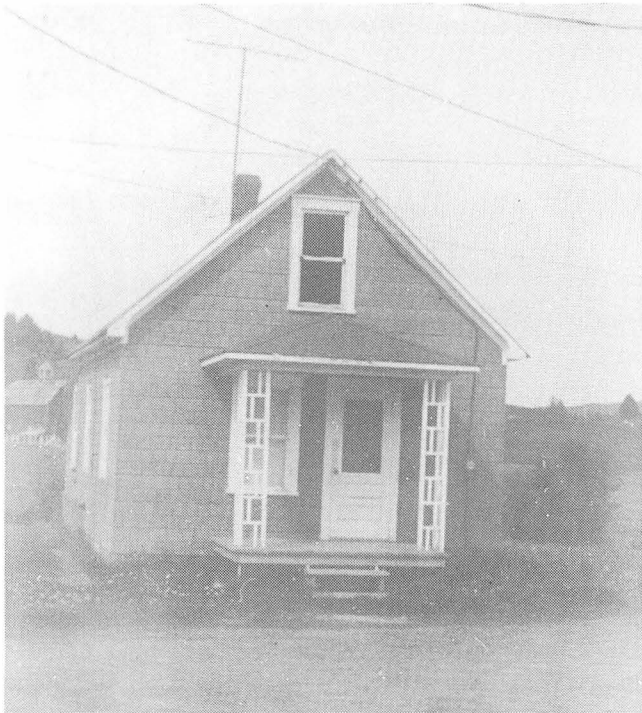
Ancienne maison de M. Chabot; elle a été transportée au village et elle est actuellement la propriété de Marcel Pivin.
