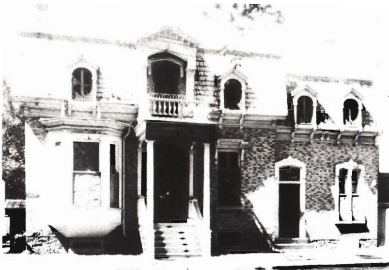
L'hôpital du docteur Bourgeois. Cette construction en brique est antérieure à 1879.
