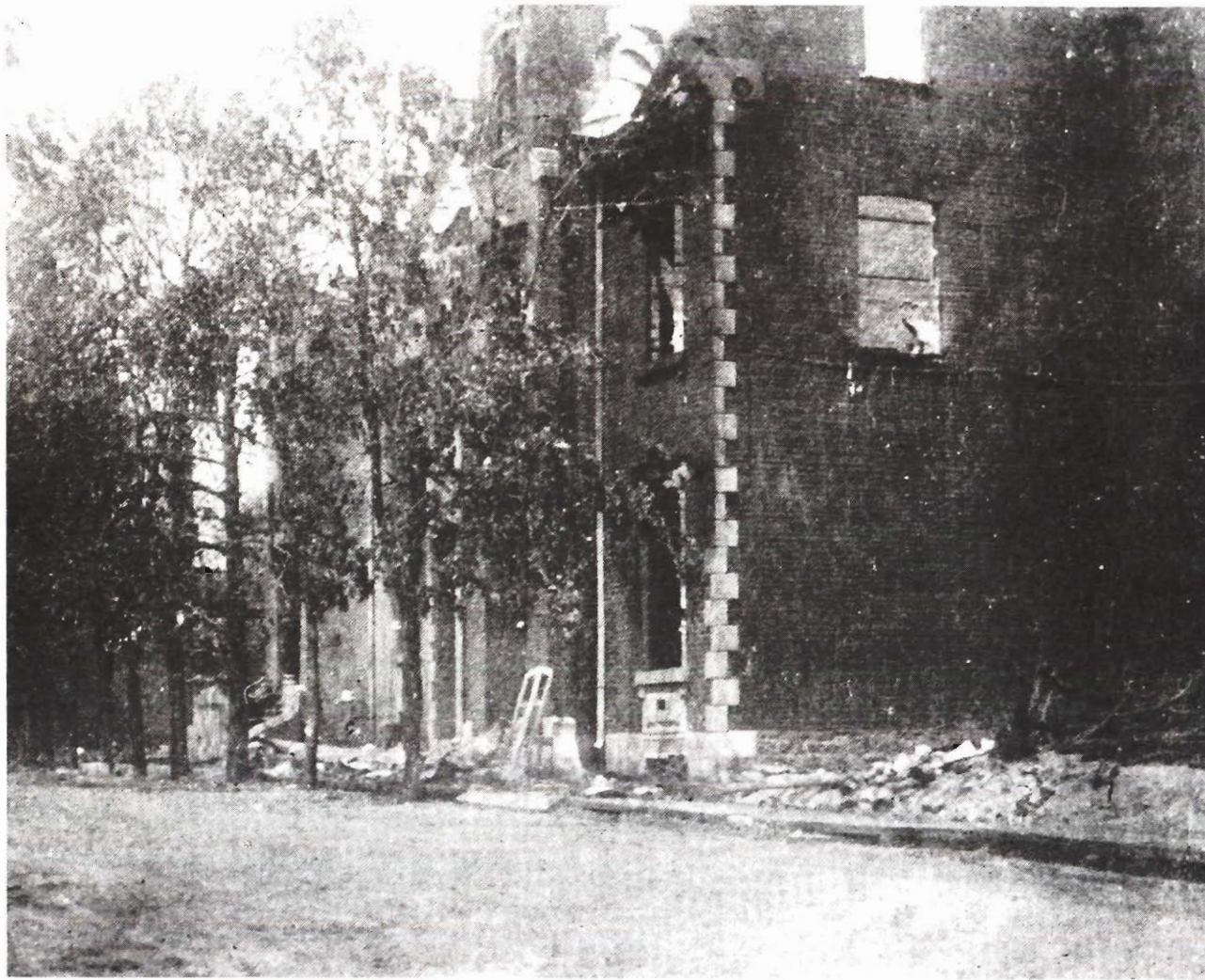
Ce qui restait du bureau de poste après l'incendie.
