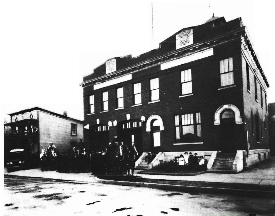
Poste de police et d'incendie toujours en service au coin des rues Lavolette et Saint-Maurice.
