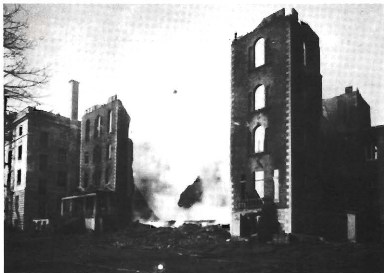
Ce qui reste du « collège à tourelles » après l'incendie qui le détruisit pendant la construction de l'édifice actuel.
