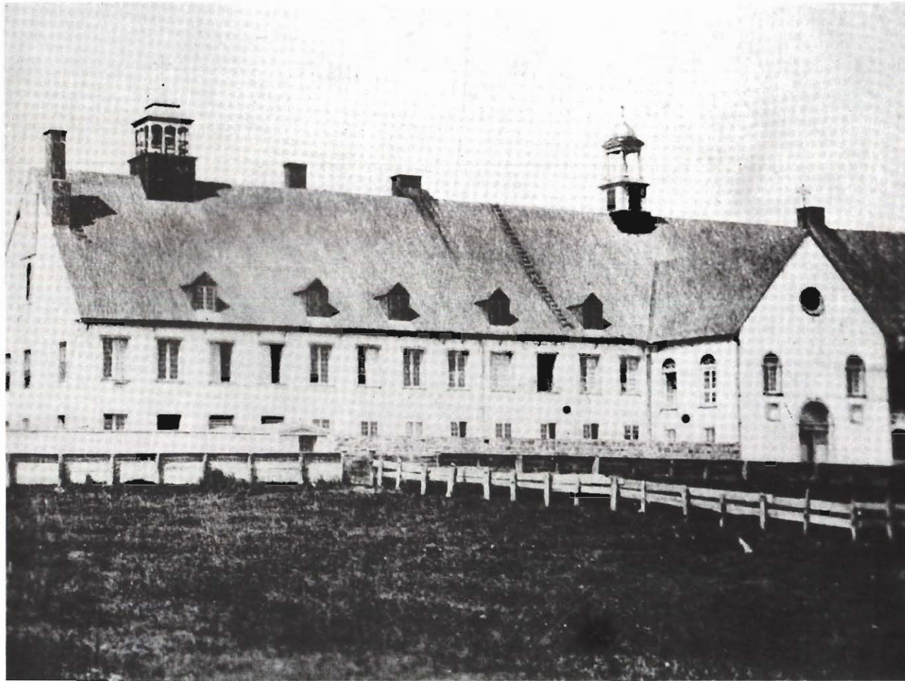
L'aile du monastère avant la réfection de la chapelle. À remarquer sur la façade la ligne marquant la limite de la maison originale et le nombre restreint des lucarnes éclairant les combles.
