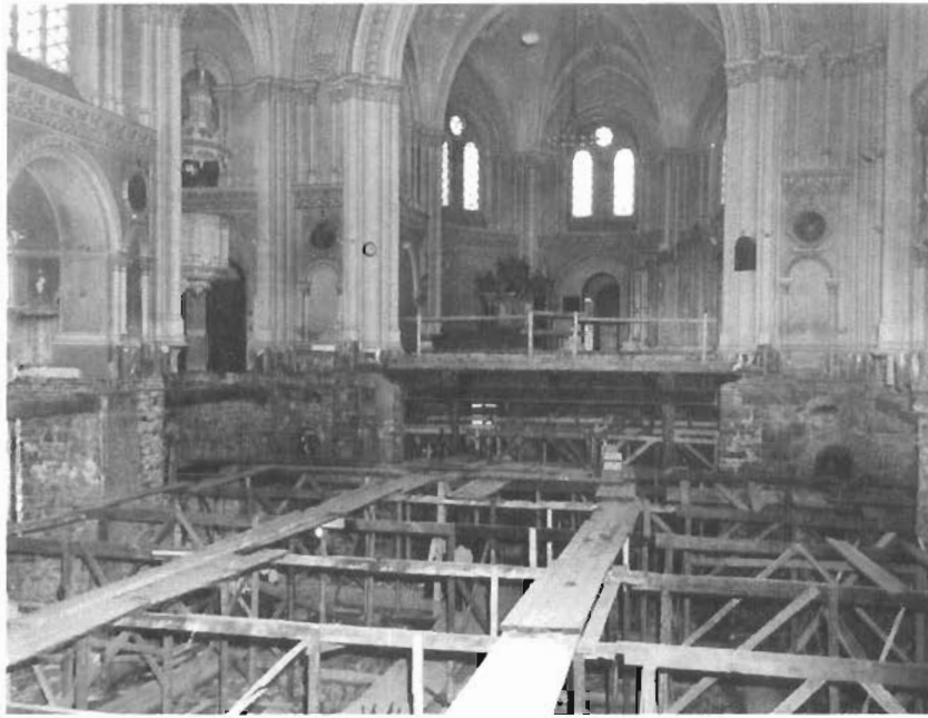
Vue d'ensemble des travaux à la chapelle (juin 1951)
