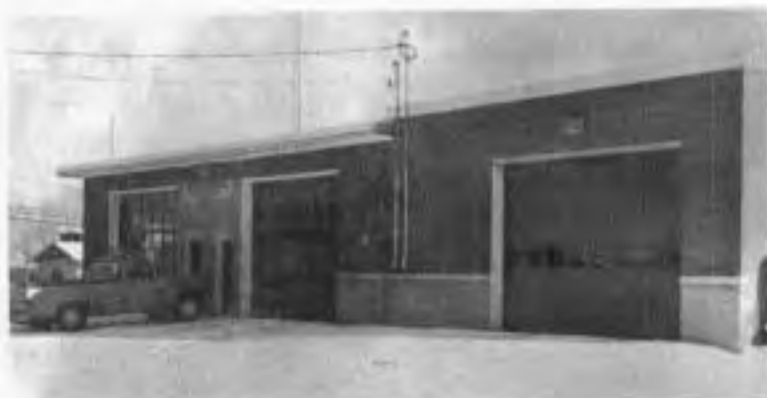
POSTE INCENDIE et GARAGE MUNICIPAL (1979)
