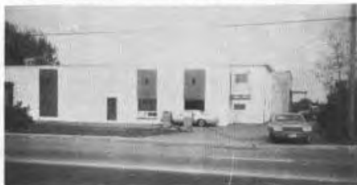
Vue partielle de l'industrie "Abattoir de la Mauricie Inc."
