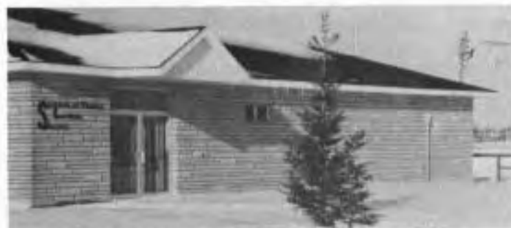
CENTRE DES LOISIRS DE ST-LOUIS-DE-FRANCE
