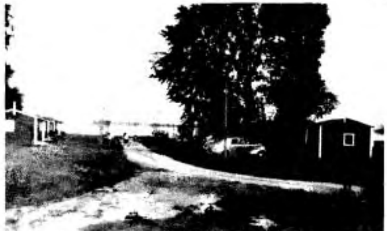
Le Sun Valley, les 12 premières cabines avant la rénovation Collection Charles Charest
