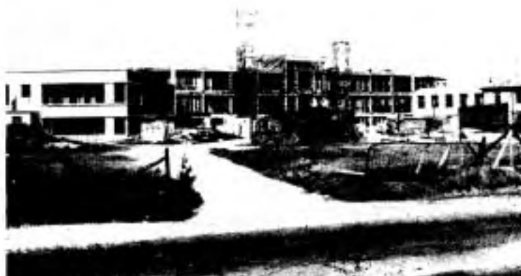
Construction de l'orphelinat
