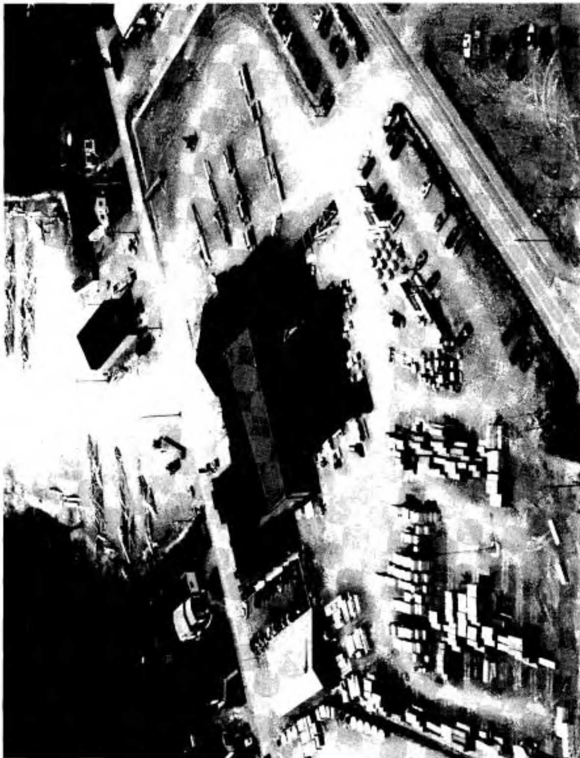
Vue aérienne de Toiture Mauricienne
