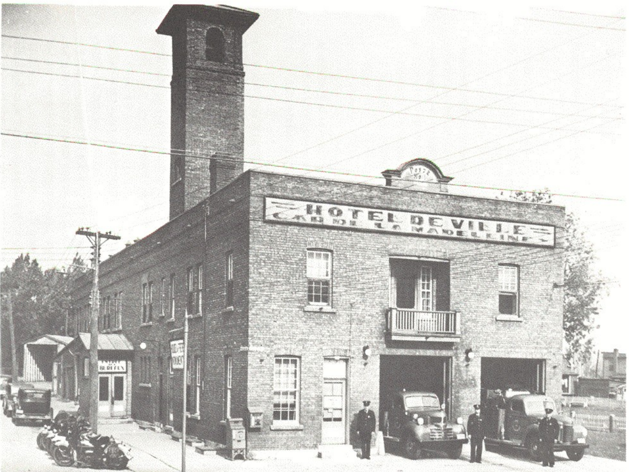
A la fin de l'année 1931 le haut de la "Station de pompes" fut entièrement transformé. La bas ne subit aucun changement sauf la construction du portique d'entrée et la pose du panneau portant les mots: "Hotel de ville - Cap-de-la-Madeleine". Cette photo fut prise quelques années plus tard.
