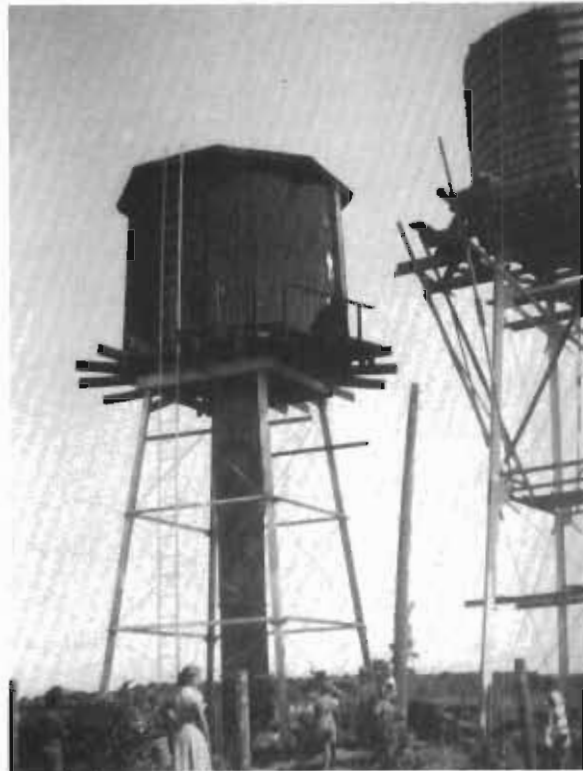
Premier réservoir à eau construit en 1902, le deuxième en 1946.
