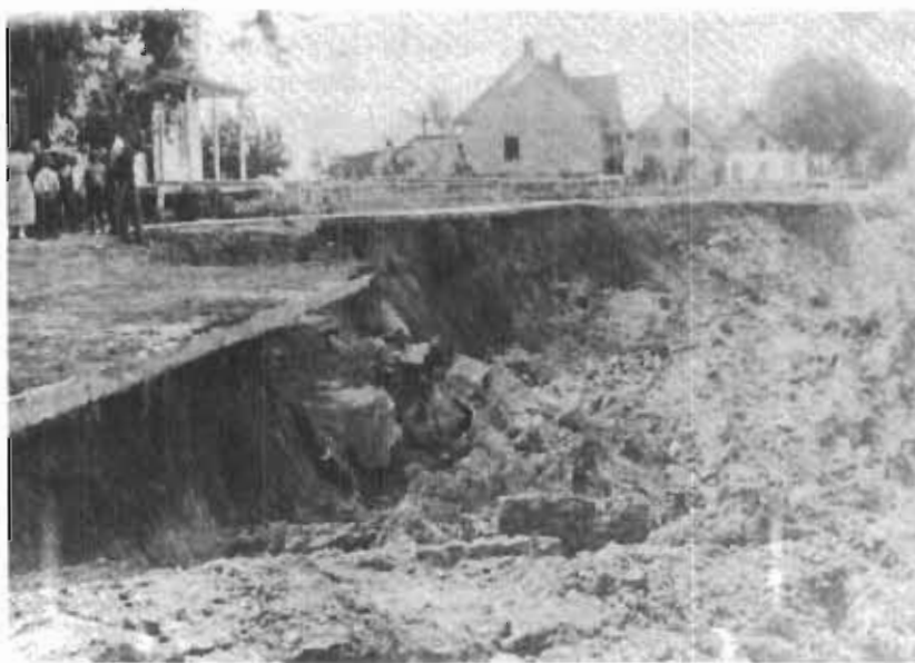
Éboulis Rue de la Gare en 1922.
