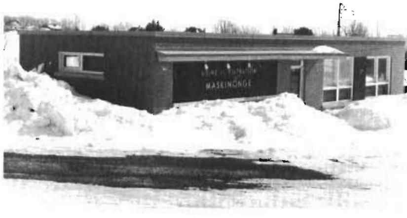
Usine de Filtration de Maskinongé, 36A, rue St-Denis.
