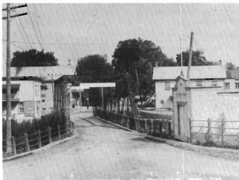
L'entrée du pont de Maskinongé, à droite la station de pompes à incendie.
