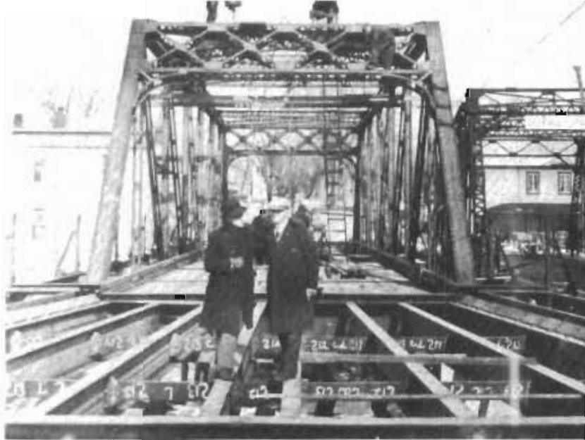
Les deux ponts en 1927. Le pont en construction est le pont Galipeault actuel. L'autre a été transporté au Bas-de-la-Rivière.
