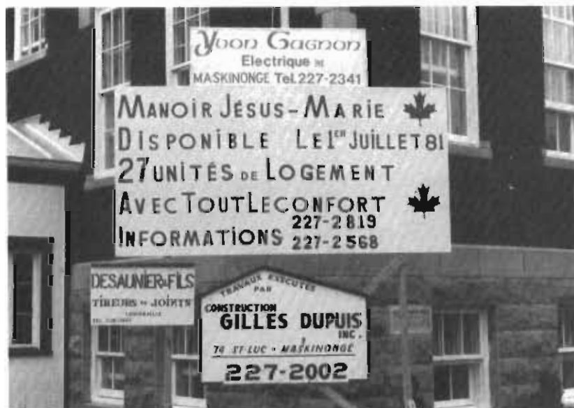
Les travaux d'aménagement du Manoir ont été effectués par les contracteurs Gilles Dupuis, Yvon Gagnon, Désaulniers & Fils comme le fait voir cette photo.
