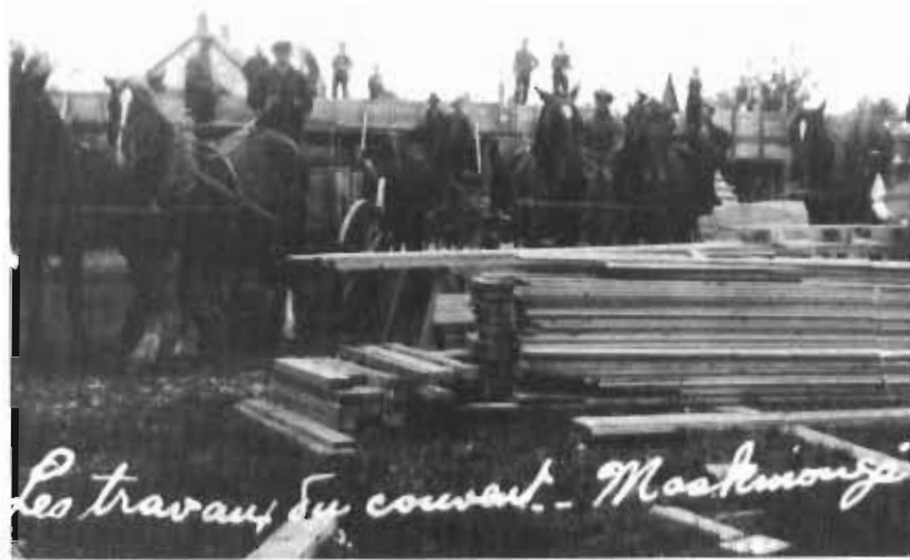
Les travaux du Couvent commencent...
