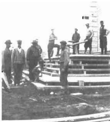
Réparation du perron de l'église.
