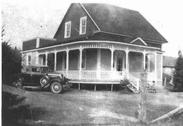
Première maison d'école après rénovation.
