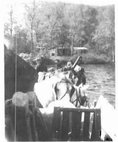
Chantier au lac Mékinac.
