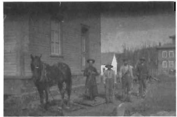
Réparation du presbytère, vers 1909
