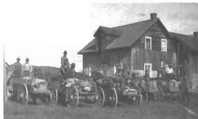
Travaux des chemins (maison de Joseph Belleville, père)
