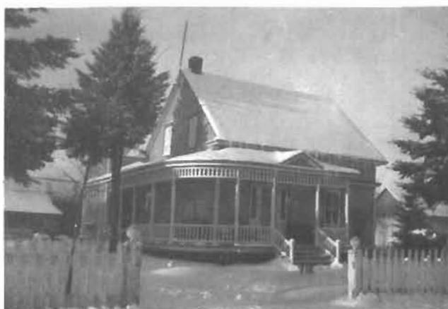
Première maison d'école après transformation. (arrondissement 1)
