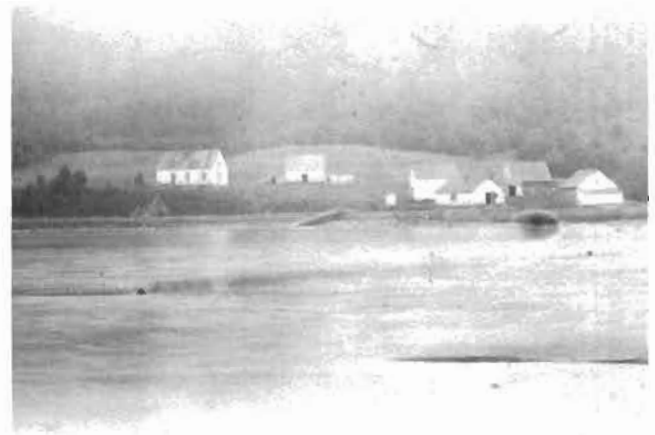
Ferme du lac Mékinac appartenant à la C.I.P.
