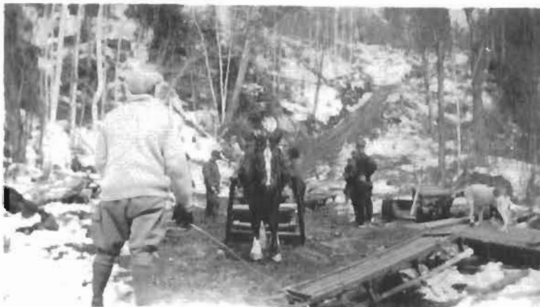
La vie de chantier.
