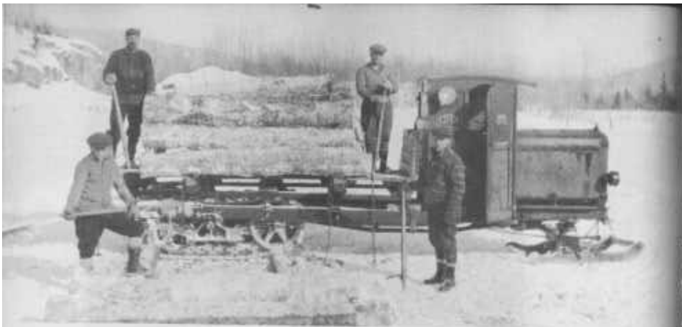
Sur les chantiers de Jeffrey Veillet : camion à chenille communément appelé « linn ».
