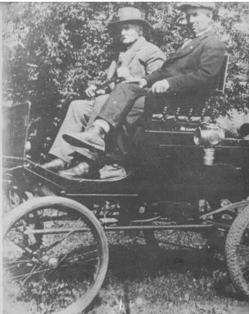
Cette élégante «Locomobile» à vapeur, fabriquée à Port Hope, U.S.A., fut acquise en 1908 par Théophile Magnan. Première auto à sillonner les routes et les rues de Sainte-Thécle, elle effrayait bétail et volatile. Capable d'une vitesse moyenne de 20 m. p. h., elle parcourait 4 milles au gallon, lequel valait 12 cents.
