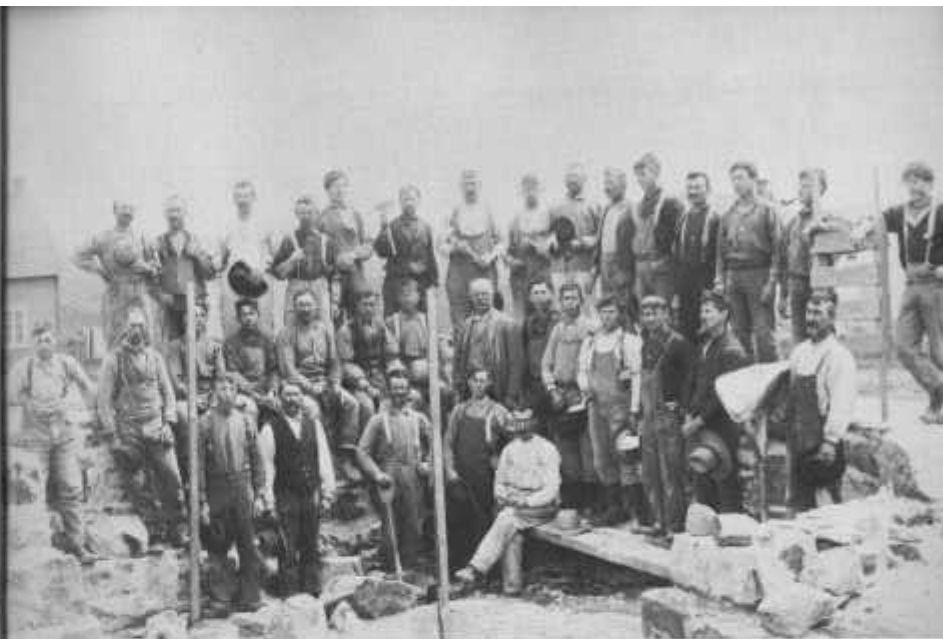
Le début de la construction de l'église sur la côte en 1902.
