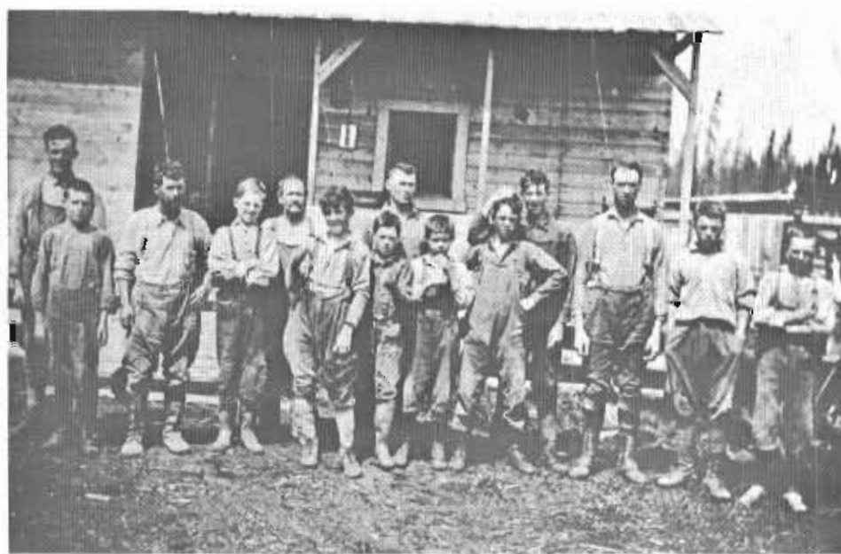
Chantier d'Eugène Germain aux Pointes vers 1915.
