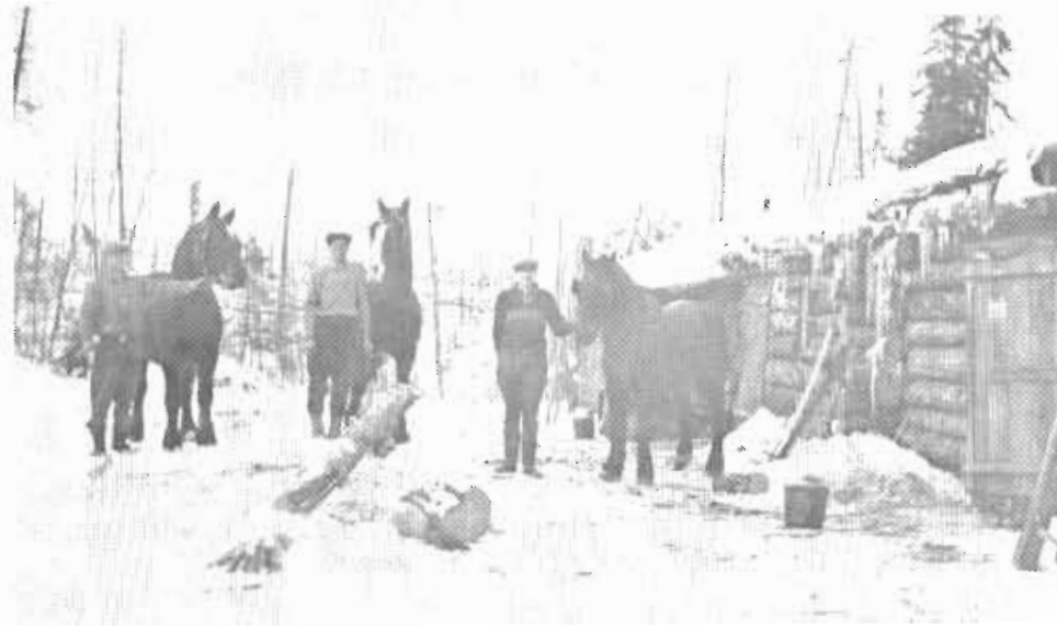
Henri Gauthier aux chantiers; il est au milieu.
