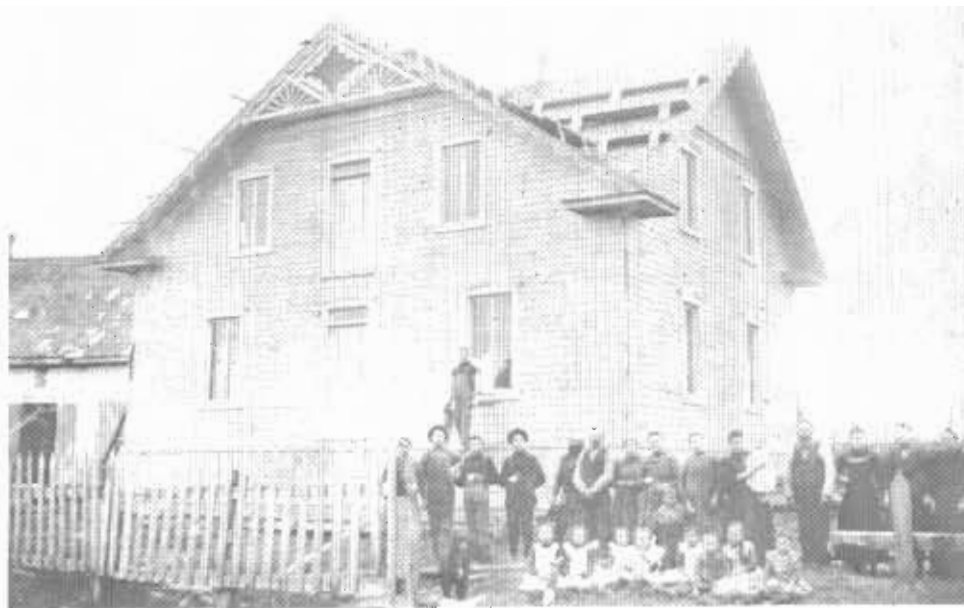
Maison de François Marchand en construction en 1896. Aujourd'hui, elle est occupée par la famille Louis Marchand et porte le no 171, Notre-Dame. À gauche, on aperçoit l'ancienne demeure de François Marchand. Elle sera déménagée sur l'emplacement voisin et appartient maintenant à Madame Jacques Hardy. Debout: Inconnu, Émile Marchand, inconnu, inconnu, Canut Trottier, Joseph (Choune) Marchand, Arthémise Ayotte, Mme François Marchand (Séraphine Dontigny), Mme Martial Massicotte (Georgianna Marchand), inconnue, François Marchand, et trois inconnues. Le menuisier qu'on voit à l'arrière se nommait Quessy.
