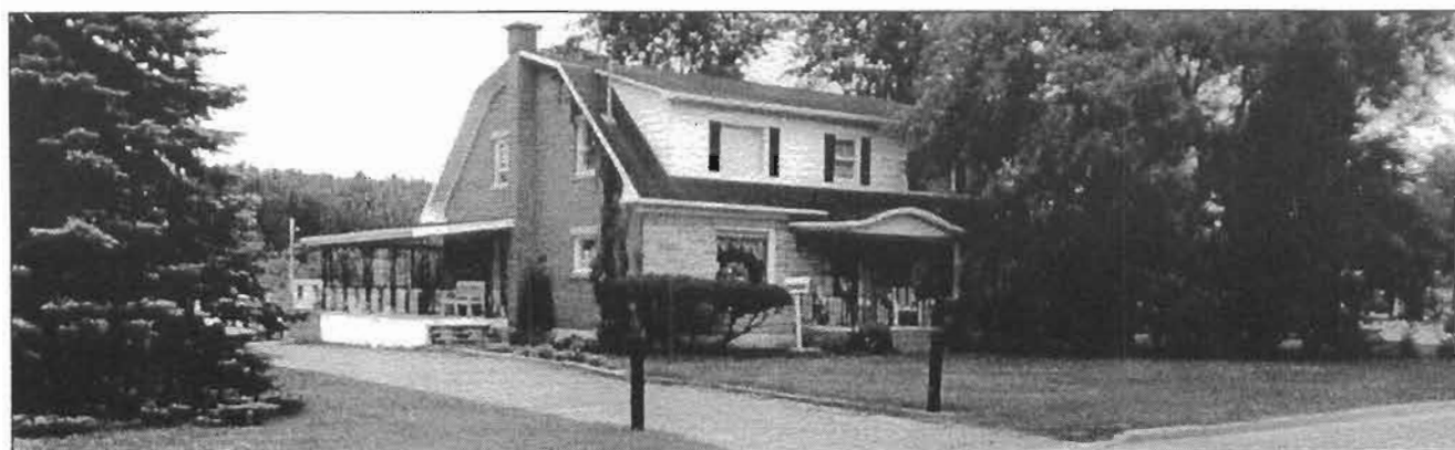
Maison familiale, construite en 1955 par Ernest Touzin
