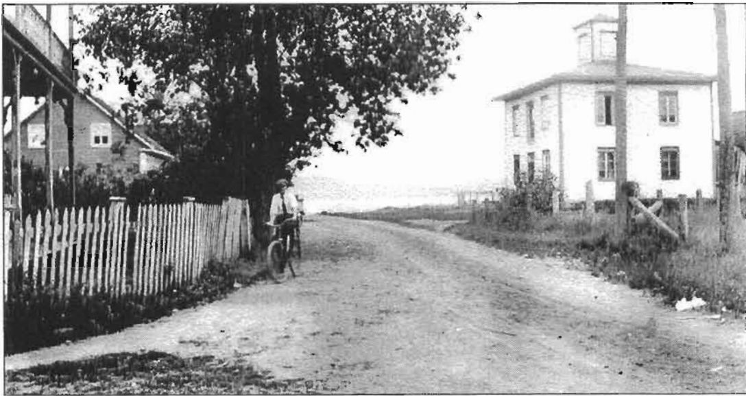
Deuxième bureau de poste
