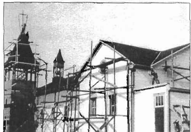
Rénovation de la chapelle
