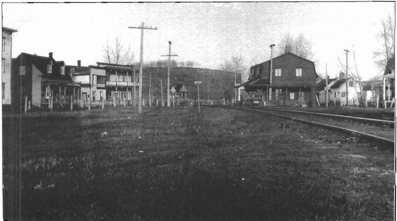
La maison de pension est celle à trois étages, à l'extrémité gauche, et la petite maison à côté est le début du magasin Simard.
