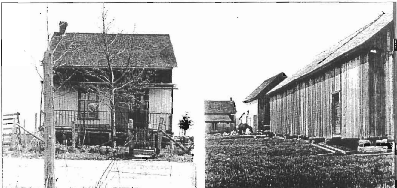
Maison et bâtiment de ferme en réparation vers 1930
