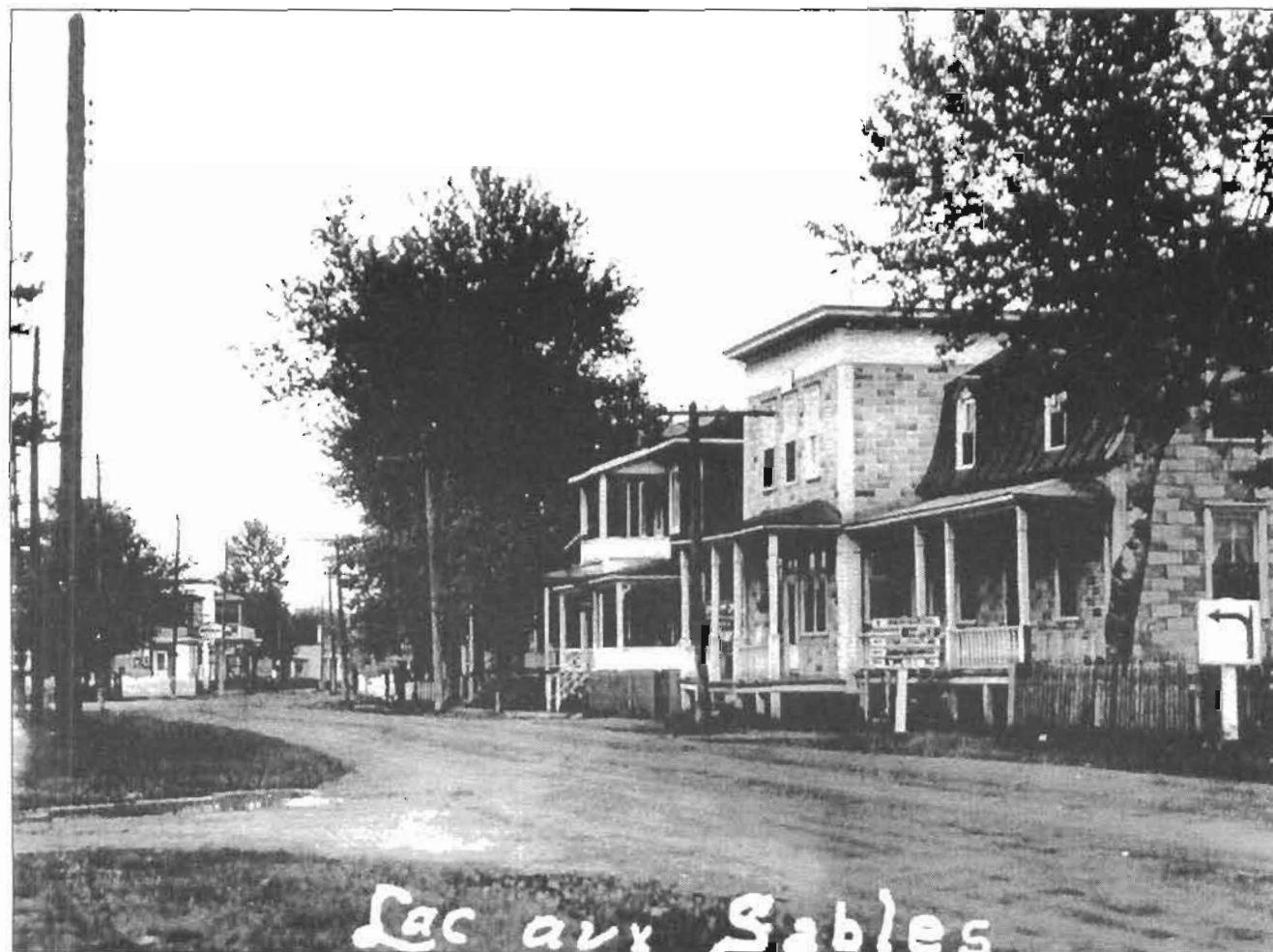
Magasin général Lavallée (2 e maison à partir de la droite)
