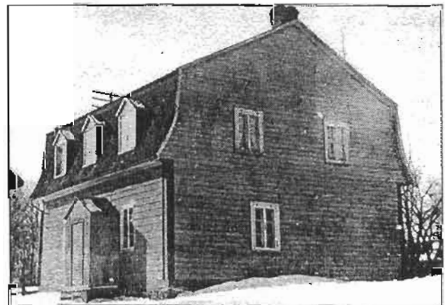
École type avec toit à la Mansard
