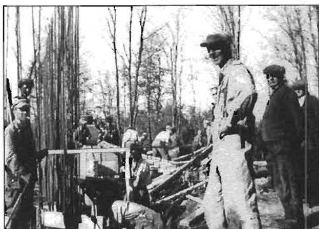
Construction de l'aqueduc
