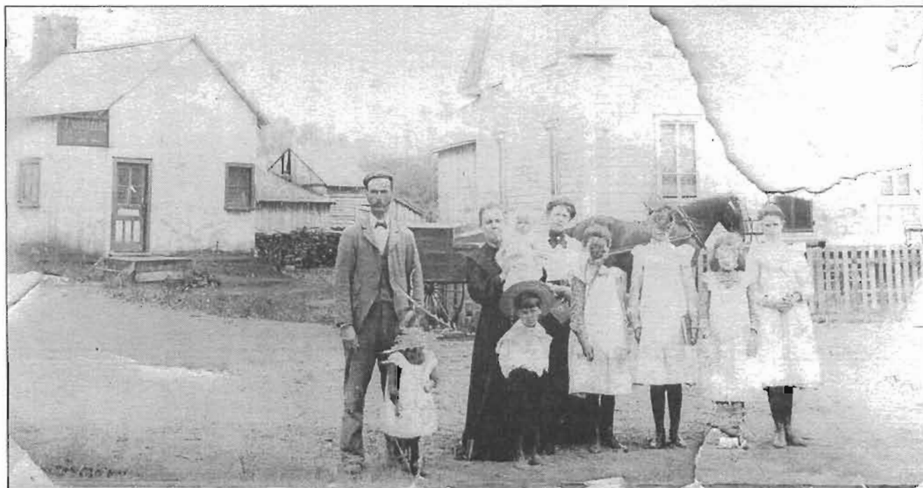
La famille et la boulangerie Gosselin à la station
