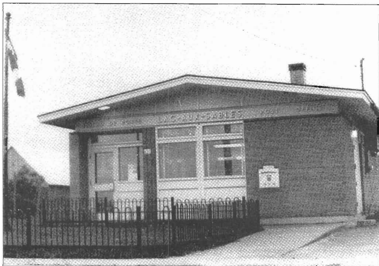
Le bureau de poste actuel
