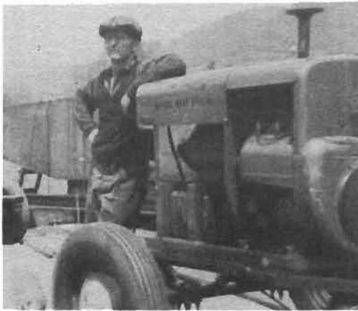
Gérard 1953. Construction chaland des Piles.
