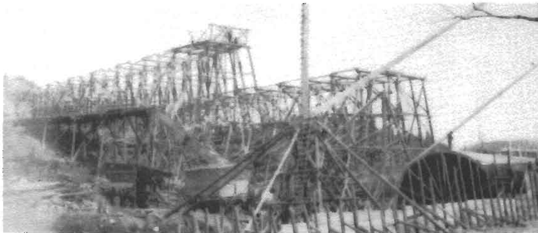
Le tressell et le petit Lac à Sinaï avant que l'eau monte près du lac le moulin de Welly Denoncourt vers 1908.
