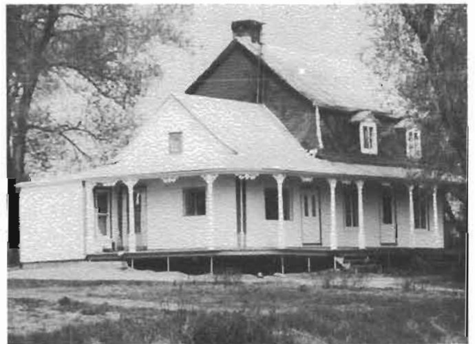
Maison familiale construite en 1873. Rénovée en 1917.
