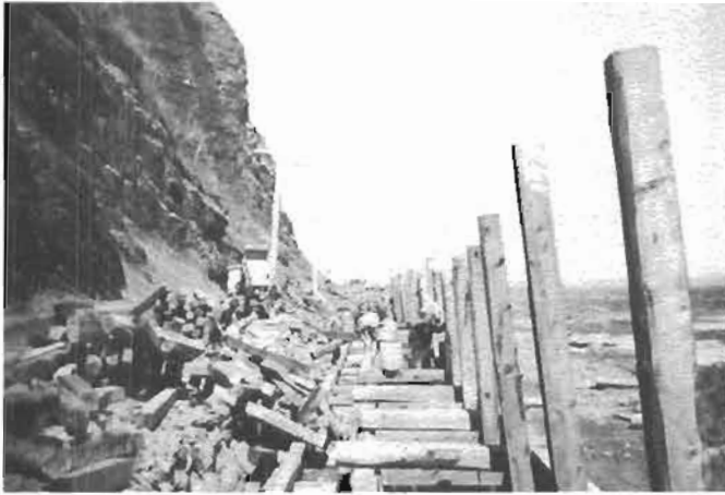
... ponceaux, calvettes et murs...
