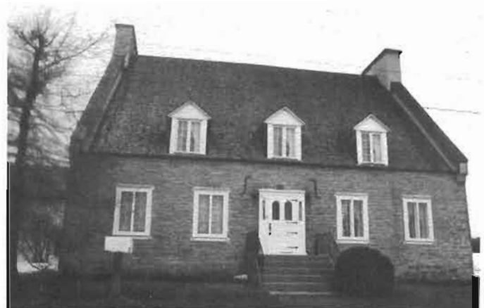
Le 200 Rapide Nord Maison de transition Franco-québécoise à pignons latéraux munis de murs coupe-feu
