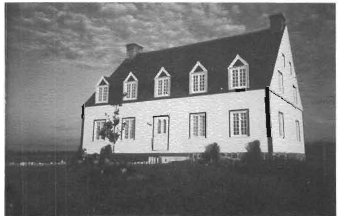
Été 1986 – La maison familiale construite vers 1815
