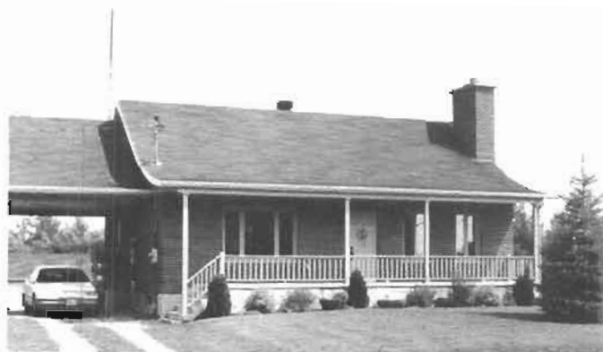
La maison de la famille construite par Normand
