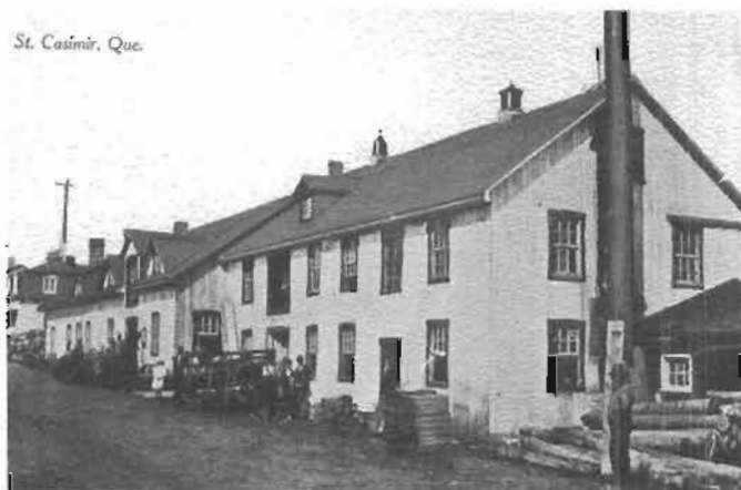
Description de la photo: La fonderie Trotter de Saint-Casimir vers 1900 et, à l'arrière-plan, l'atelier de menuiserie. Les deux bâtiments présentent une construction de forme rectangulaire, comportant deux étages et des murs en bois de charpente surmontés d'un toit à deux pentes en bardeaux. Un nombre substantiel de fenêtres hautes assurent la ventilation et probablement la pénétration de la lumière naturelle, avant l'arrivée de l'électricité, alors que la façade dispose de larges portes permettant la circulation de la machinerie et des marchandises. À noter la cheminée du haut fourneau attenante au mur ouest, les billots de bois et, à l'avant, des véhicules et instruments aratoires qui viennent probablement prendre livraison ou décharger de la marchandise. Sauf quelques modifications, ces structures seront conservées du moins jusque vers 1950. (Collection: Jean-Luc Trotter)
