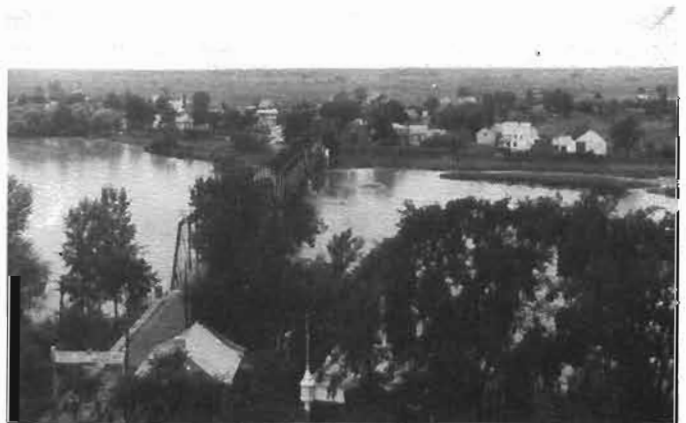
Le vieux pont de fer et l'ancienne maison de péage.
