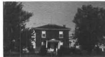
La maison familiale d'Arthur Lacoursière construite en 1915-16
