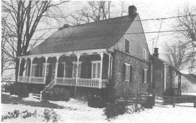
Le 830 rue Principale Maison de transition Franco-québécoise à pignons latéraux (armiers incurvés)
