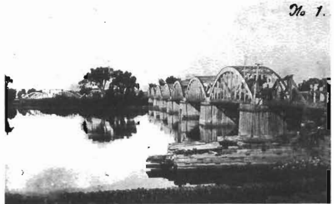
Pont de bois construit en 1860 et emporté par l'éboulement de 1894. Ce pont était un pont-levis dont la première arche s'ouvrait pour laisser passer les bateaux.
