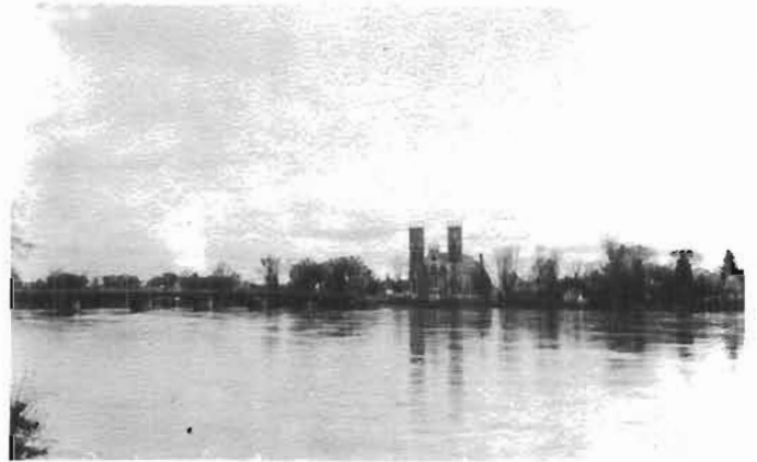
Magnifique vue de la rivière, de l'église et du pont à une période où l'eau était très haute.
