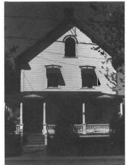
La maison familiale construite en 1877
