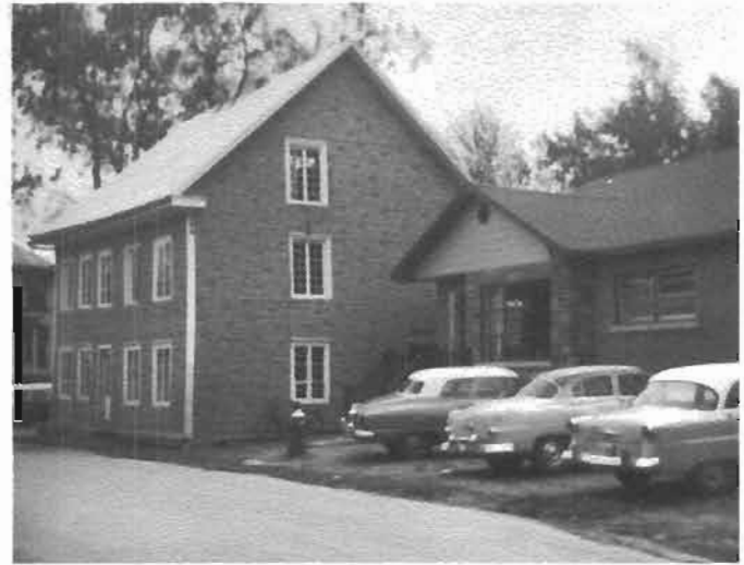
L'ancienne et la nouvelle maison de Jules Godin lors de la construction de celle-ci en 1958.
