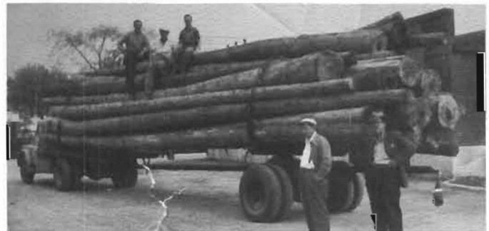
Au premier plan à gauche, Antonio Ricard. Un chargement de poteaux de la Provincial Pole Line Construction Ltd.
