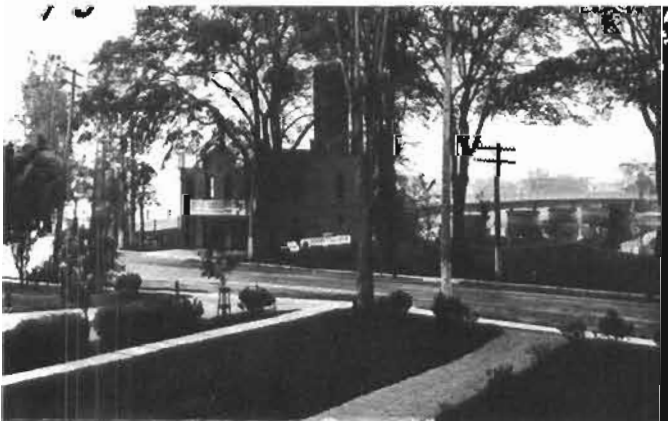
L'Hôtel de ville du village avec la tour pour le séchage des boyaux.
