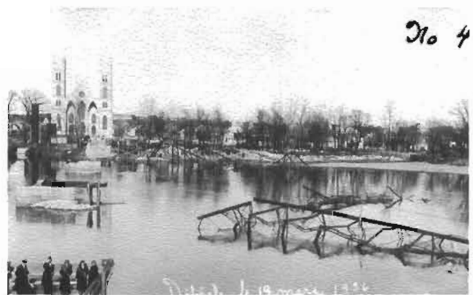
Démolition le 19 mars 1936
