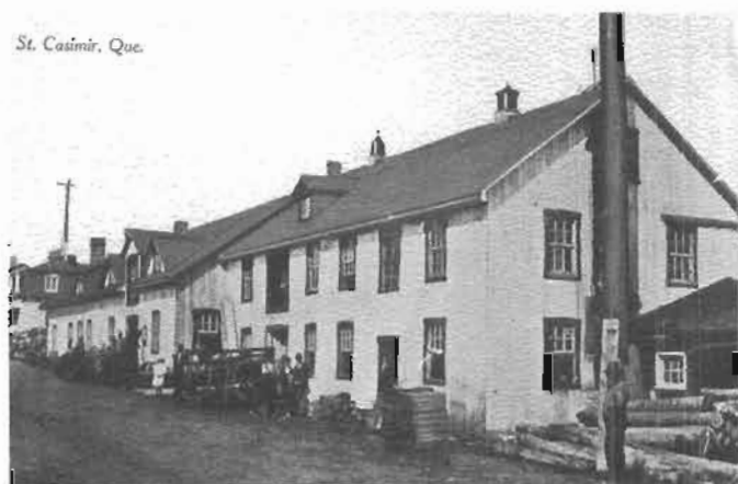
Description de la photo: La fonderie Trottier de Saint-Casimir vers 1900 et, à l'arrière-plan, l'atelier de menuiserie. Les deux bâtiments présentent une construction de forme rectangulaire, comportant deux étages et des murs en bois de charpente surmontés d'un toit à deux pentes en bardeaux. Un nombre substantiel de fenêtres hautes assurent la ventilation et probablement la pénétration de la lumière naturelle, avant l'arrivée de l'électricité, alors que la façade dispose de larges portes permettant la circulation de la machinerie et des marchandises. À noter la cheminée du haut fourneau attenante au mur ouest, les billots de bois et, à l'avant, des véhicules et instruments aratoires qui viennent probablement prendre livraison ou décharger de la marchandise. Sauf quelques modifications, ces structures seront conservées du moins jusque vers 1950. (Collection: Jean-Luc Trottier)
