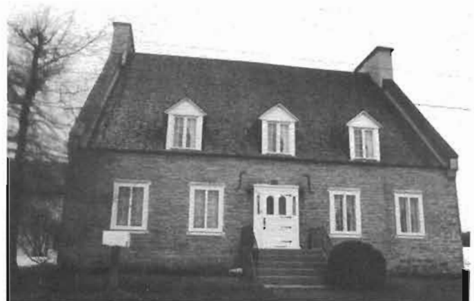
Le 200 Rapide Nord Maison de transition Franco-qubécoise à pignons latéraux munis de murs coupe-feu
