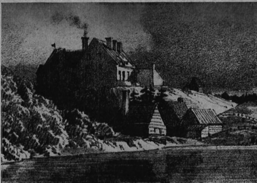
La Grande Maison, telle que reproduite dans le volume de l'arpenteur Bouchette : British Dominions in North America , (1832). — Au pied de la côte, la forge basse transformée en manufacture de haches. La cheminée est encore debout.
