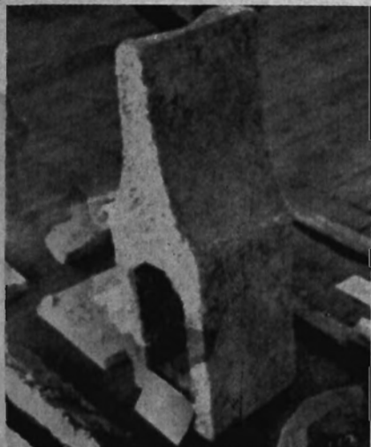
★ Gros marteau trouvé sur le site des Forges de Saugus : masse de fer de 505 livres. Cette masse servait à affiner la fonte. Le Gros Marteau des Forges de Saint-Maurice a donné naissance à des légendes où le diable joue un rôle pittoresque. ★
