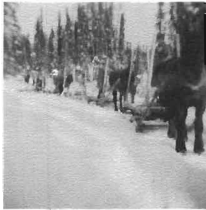
Au chantier, en caravane.
