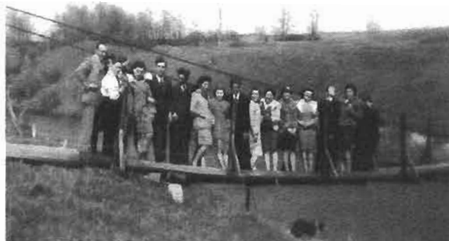
Les enfants du rang Saint-Joseph Ouest traversaient sur ce pont pour aller à l'école N° 2 au rang Saint-Alexis. Pont démoli, il y a à peu près 25 ans
