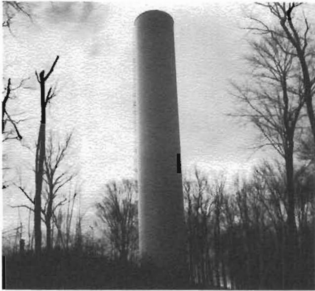
Le réservoir d'aqueduc municipal bâti sur le terrain acheté de Marie-Blanche Beaudoin.
