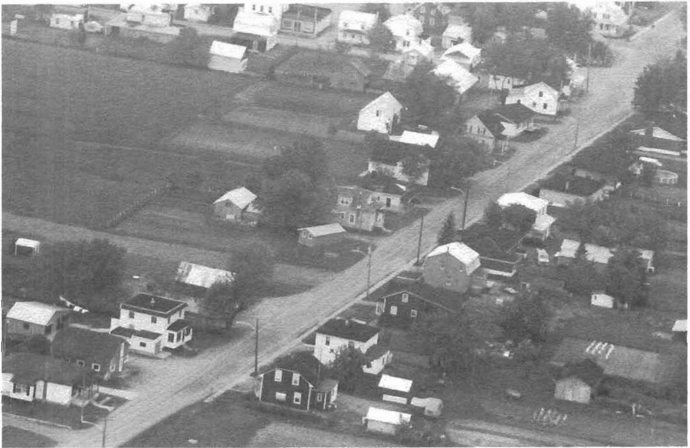
Rue Saint-Alexis Ouest en 1979 (MAC C 79.473.3A)
