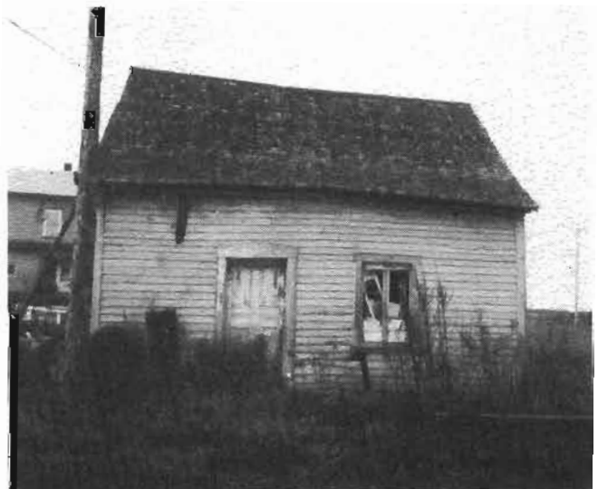
Une des premières maisons de Saint-Luc. Conservée et située sur le terrain de M. Gérard Dufresne, au 4191 rang Saint-Alexis.
