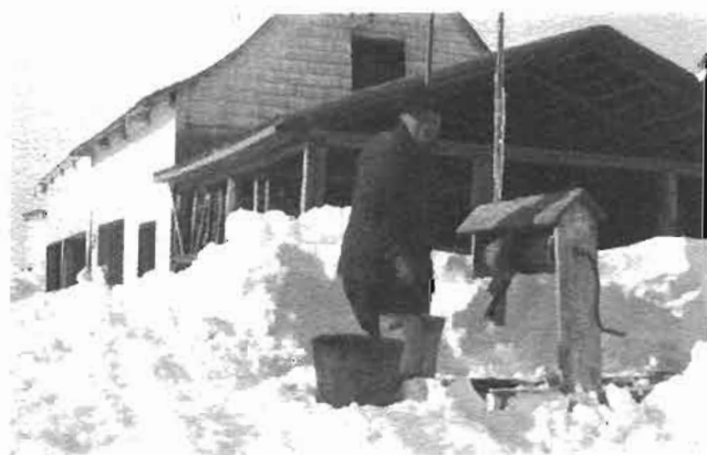
Eau. Chaque famille avait son puits Photo: - Philippe O. Beaudoin à son puits. Emplacement -résidence actuelle de Robert Beaudoin, fils de Paul
