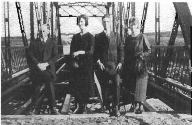
Pont de fer en construction (près du cimetière) 1921. De gauche à droite: M. Boucher, ingénieur, Véronique, Jos et Cécile Rheault. En avril 1920, la crue des eaux emportait le pont en bois. L'événement s'est produit la veille du mariage de Marie Rheault et Réal St-Arnaud. Ils ont dû traverser en chaloupe pour aller prendre le train à Champlain, pour leur voyage de noces.
