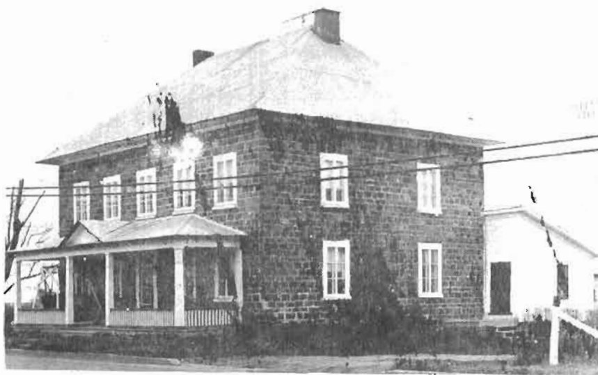
La maison de M. Oscar Chartier. C'était un poste de relais pour le service des postes et des voyageurs entre Québec et Montréal.
