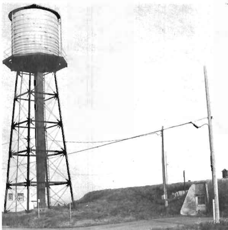
Réservoir d'eau remplacé par des pompes à pression depuis novembre 1978.
