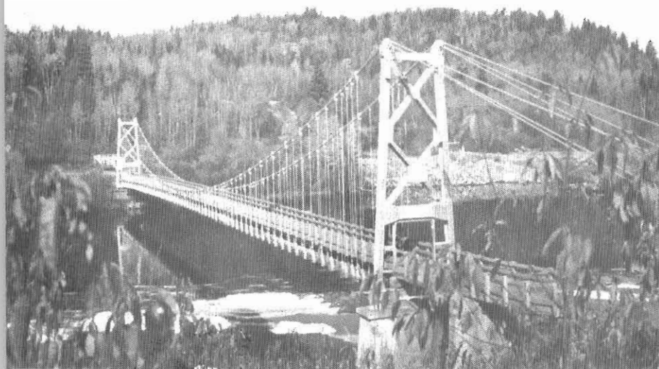
Pont suspendu sur le Saint-Maurice, acquis par la ville de la Cie Internationale de Papier.
