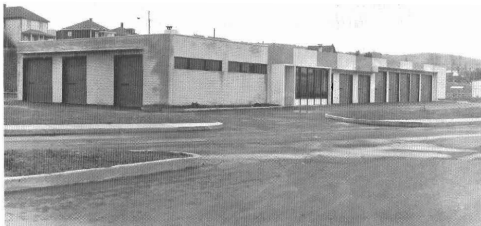
Le nouveau garage municipal, Chemin du Colisée.
