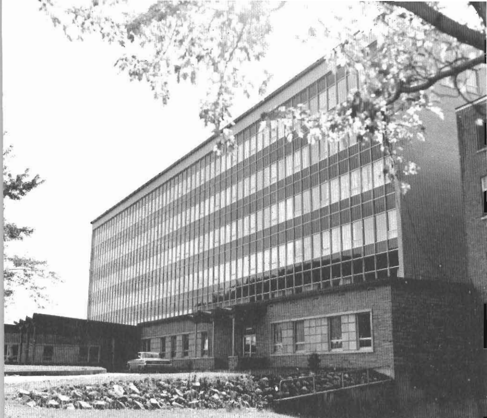
L'Hôpital Saint-Joseph, construit en 1960.
