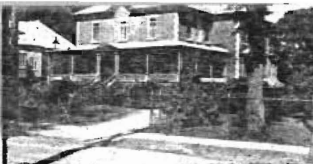
Le presbytère construit en 1932.
