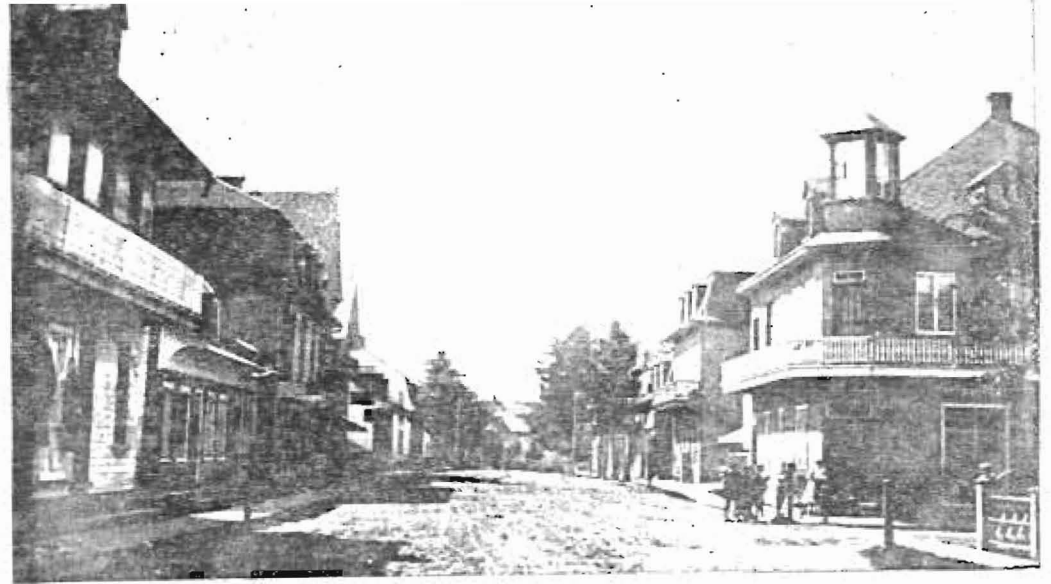
Partie du village incendiée le 25 juin 1899.
