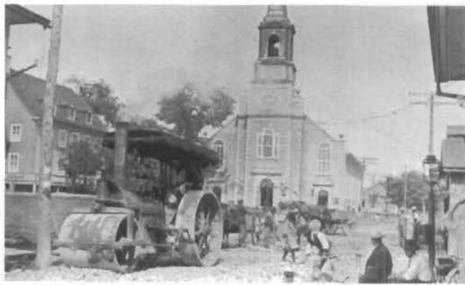
Pose du macadam sur le chemin du Roy en 1915
