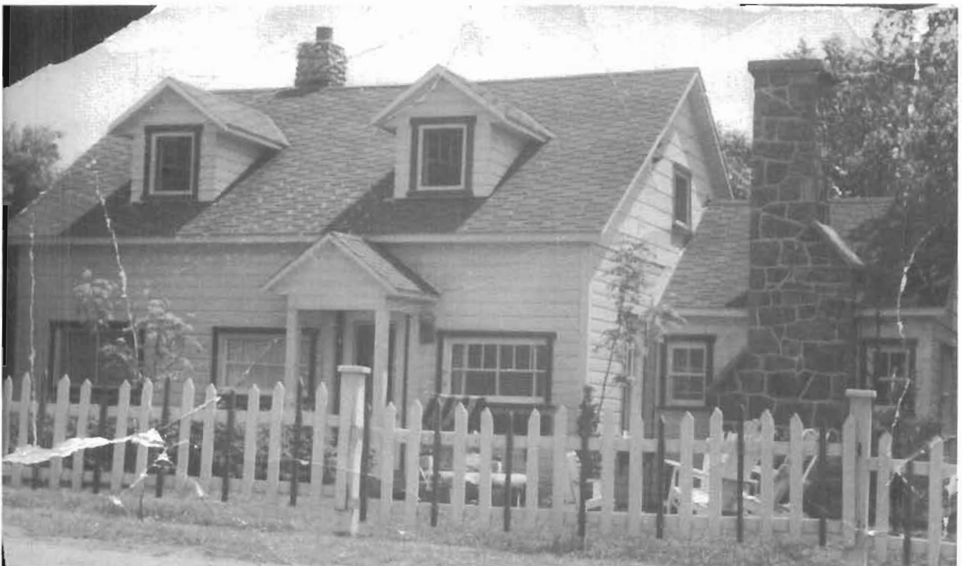
Maison Lauréat Jobin en 1950, aujourd'hui située au 461 rue des Érables et occupée par Martin Jobin
