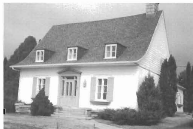
Maison Maurice Grenier, 270, rue des Érables
