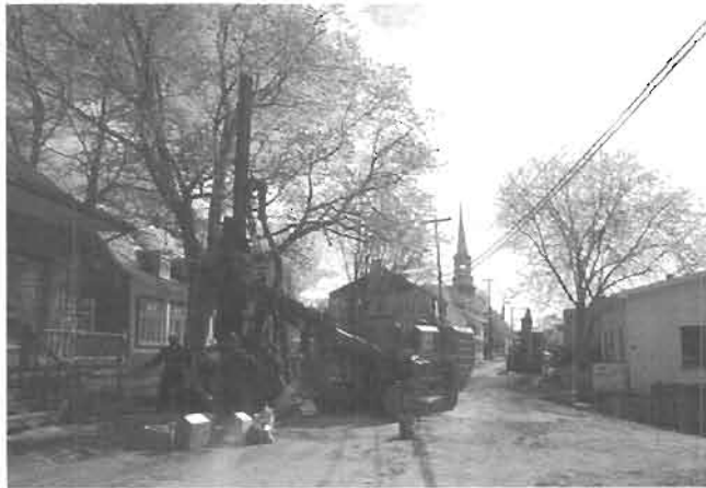
Chantier d'aqueduc et d'égouts (2000)
