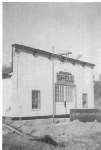
Garage Robert Bouffard, lors de sa construction, sur la route 138 à Neuville
