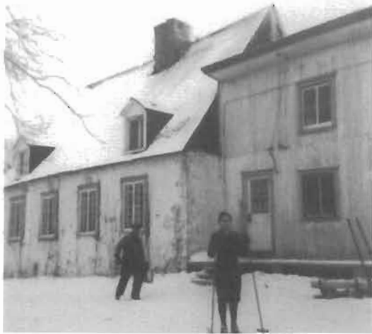
Maison Angers, 236, rue Jean-Basset
