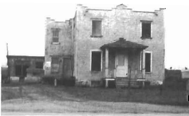
Maison Elzéar Bédard, le 24 juillet 1947, avant les rénovations
