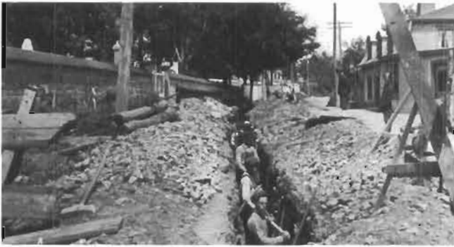
Travaux d'aqueduc... en 1911 !
