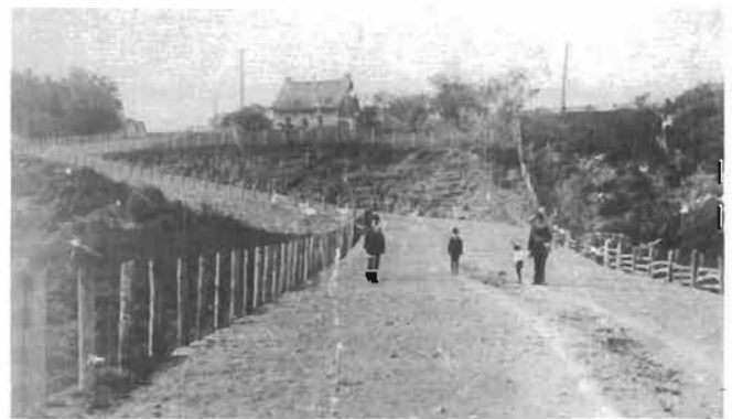
Ouverture du chemin du Quai
