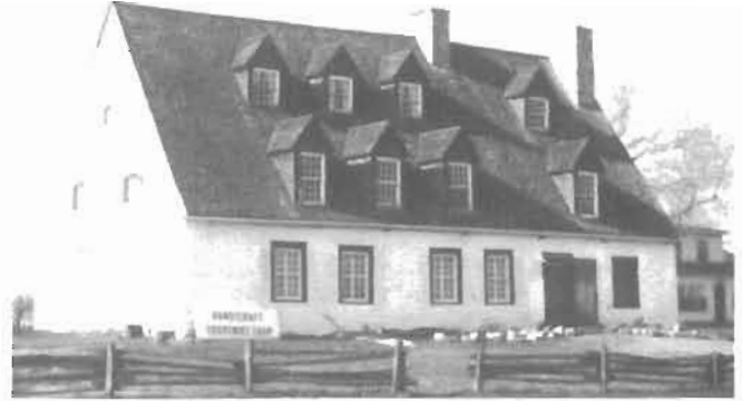
Maison Denis ou Maison Grand-Mère, 1208, route 138 Ouest
