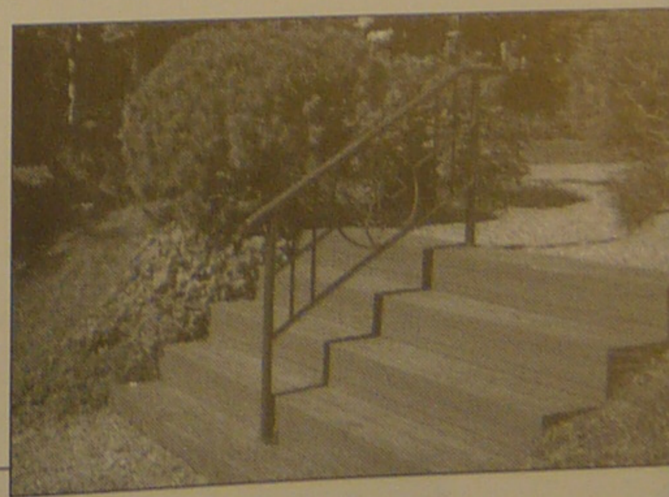
Rampes installées en 1983.
