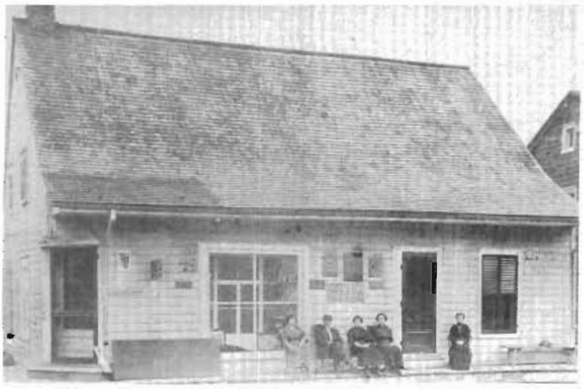
MAISON FALARDEAU _ DEMOLIE EN 1965. _
