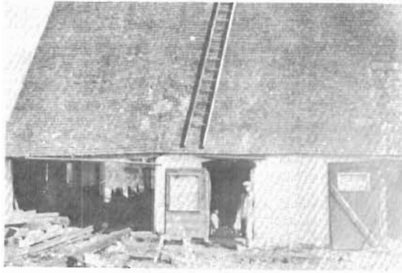
MOULIN MATTE AVANT LES RENOVATIONS.
