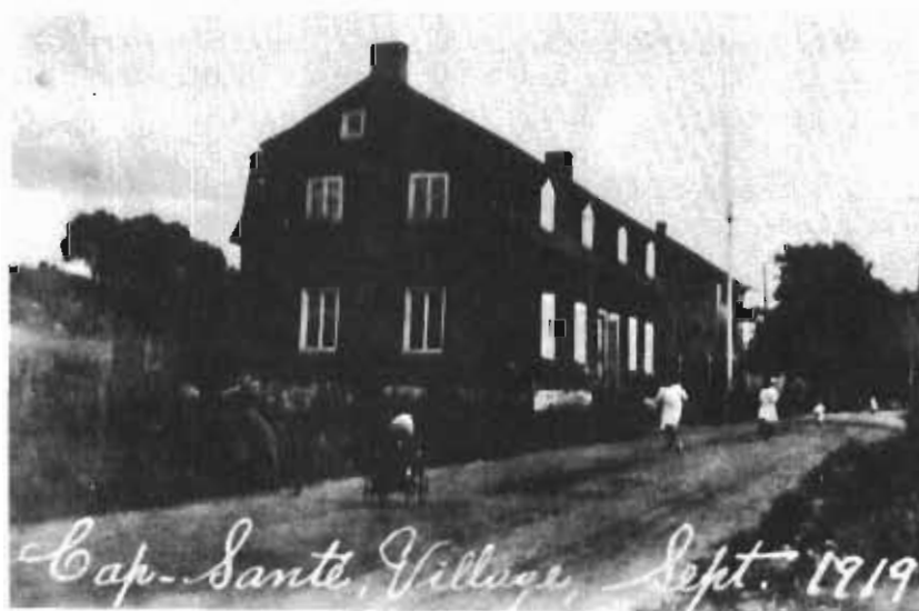
ANCIENNE ECOLE DU CAP-SANTÉ VILLAGE (ARRONDISSEMENT # 2).
