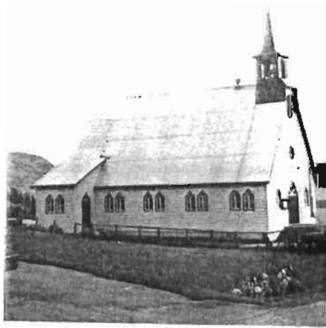
(Eglise de St-Adolphe)
