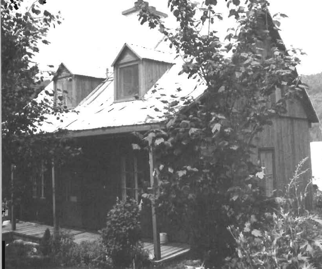
La maison des Whelan au third range , juillet 1981. Quand Gerald Whelan a cessé de cultiver, il a vendu sa terre et la maison du même coup. Du temps des Whelan cette maison était un log house ou maison de bois rond. Le lambris de planche est relativement récent.
