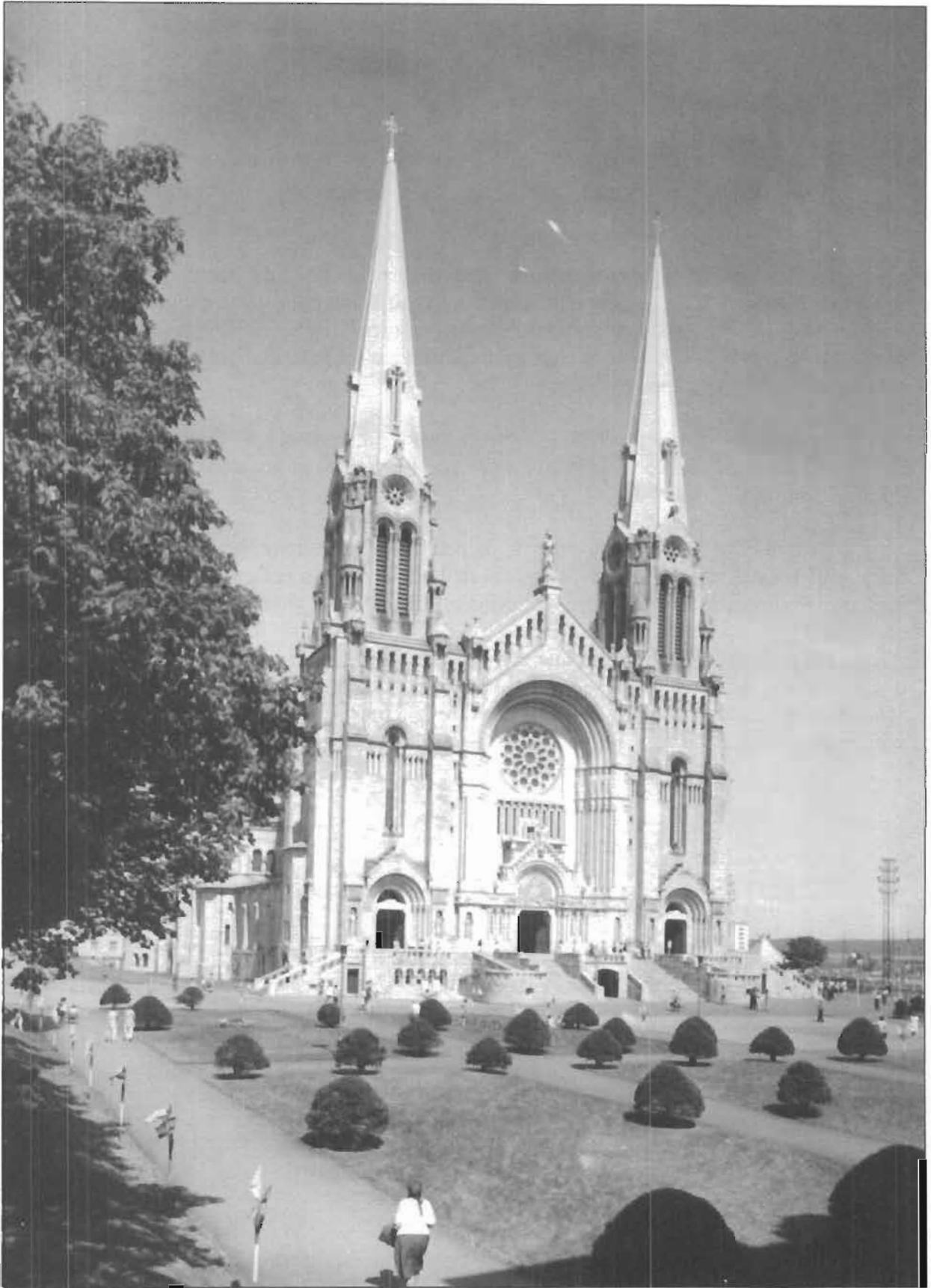
Basilique avec ses clochers finis.
