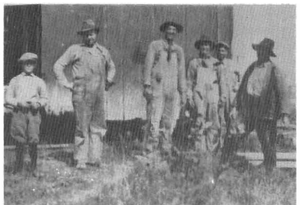
On démolit la vieille grange. Demolishing the old barn on Félix Pinsonneault's farm: Sylvio Pinsonneault, Albert Quenneville, Félix (Sylvio's father), Sam Guilbeault, Alfred Moison and Louis Désilets.
