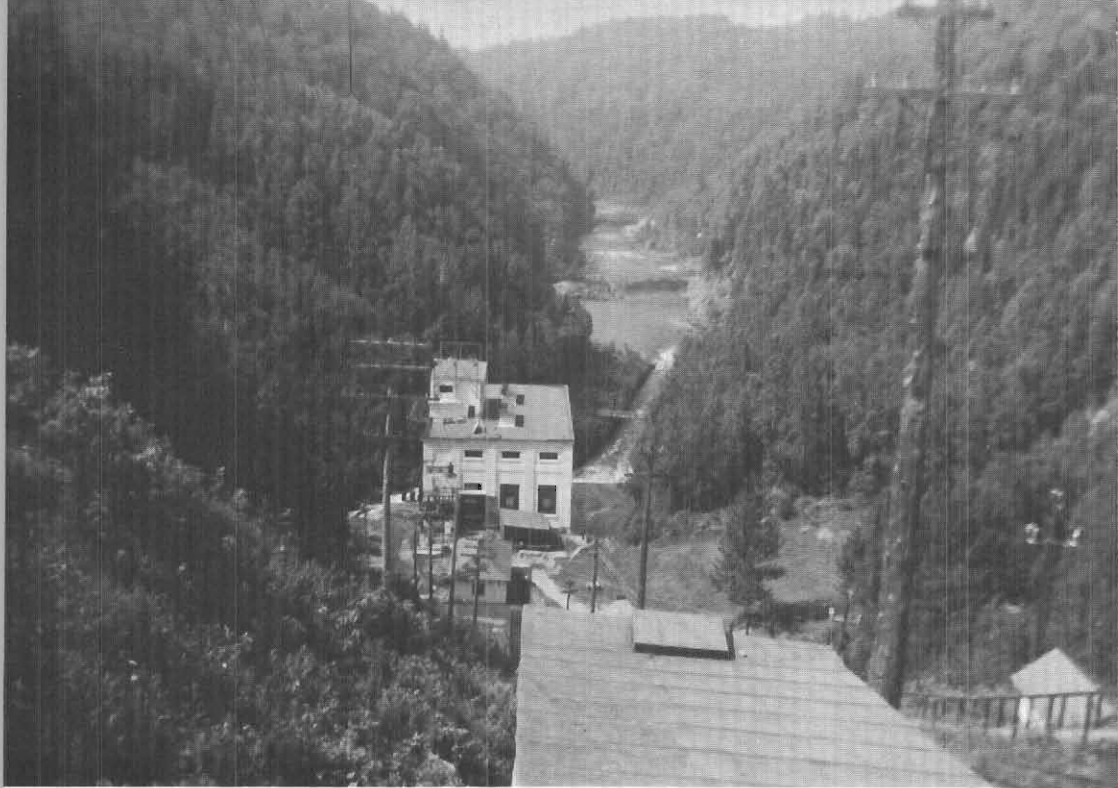
Centrale des Sept-Chutes avec, au fond, un panorama de la rivière Ste-Anne.
