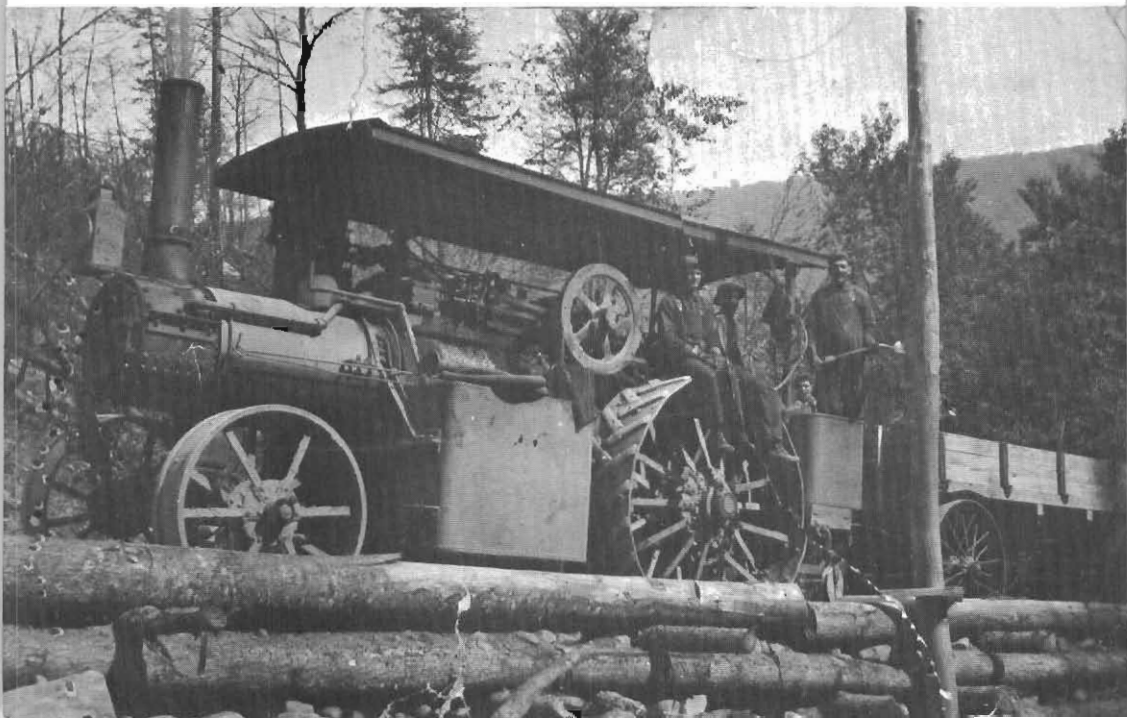
Locomotive à vapeur sur roues de bois, lors de la construction du barrage.
