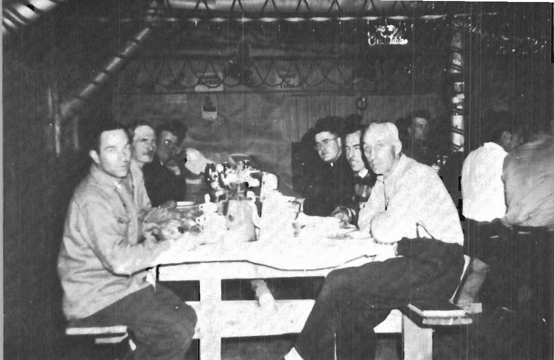
Un Noël dans les chantiers, au Keable en 1948.
