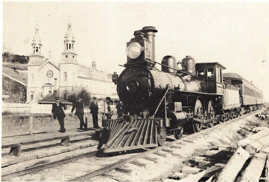
La Basilique avant l'incendie de 1922 (5)
