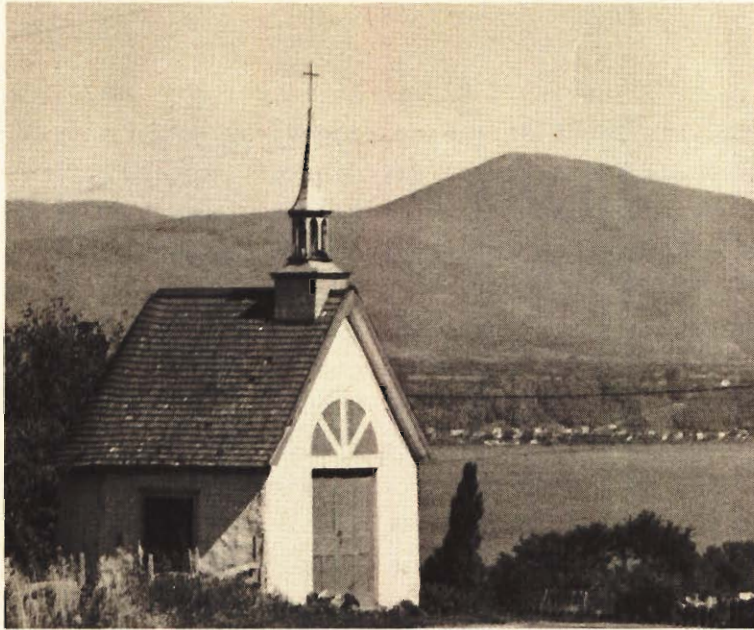
Quelle force et quelle puissance que ces montagnes p.3 (2)
