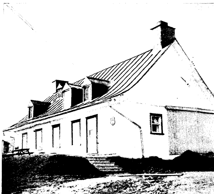
Maison de l'ancêtre Jacques Vézina sise au 5496, Avenue Royale, à Boischatel.
